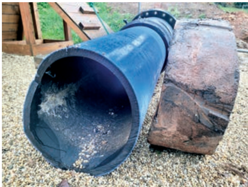
Ocelová potrubí na hraně životnosti nahrazuje VaK Zlín moderním materiálem
