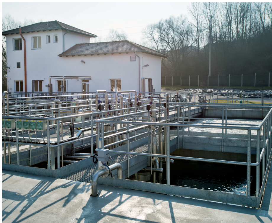
Čistírna odpadních vod ve Starém Plzenci
