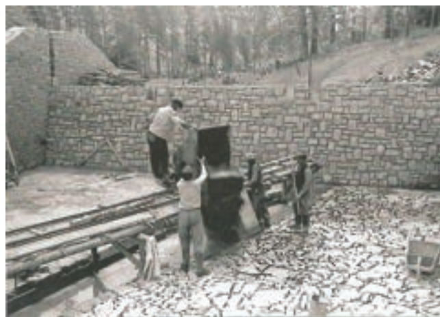
Výstavba vodní nádrže Chotobuš, rok 1950
