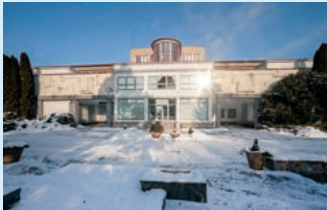
Úpravna pitné vody v Podhradí u Vítkova, kde SmVak dokončily za 130 milionů korun komplexní rekonstrukci strojně-technologického zázemí
