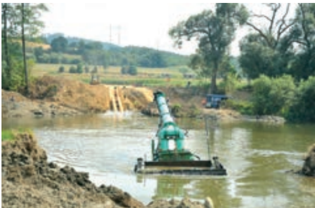
Obr. 7: Zatahování shybky pod řekou Sázavou
