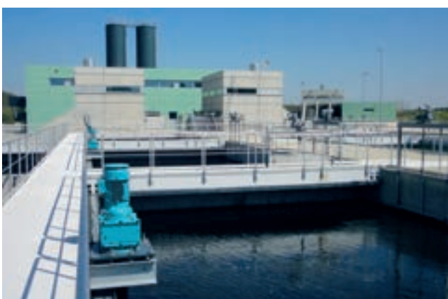
Obr. 1: Používání práškového aktivního uhlí na čistírně odpadních vod Steinhäule, Ulm/Neu-Ulm
