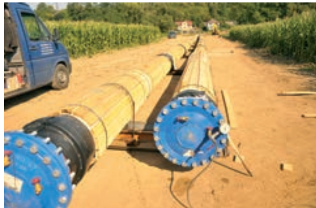
Obr. 8: Obložení potrubí shybky prkny
