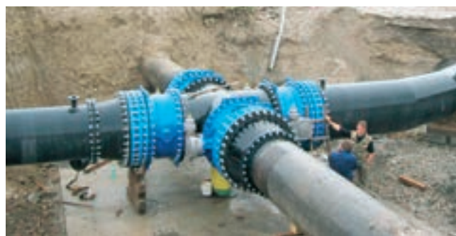
Praha, Heinzelova, armaturní kříž DN 1 200, 128 závitových tyčí, 640 ks matic
