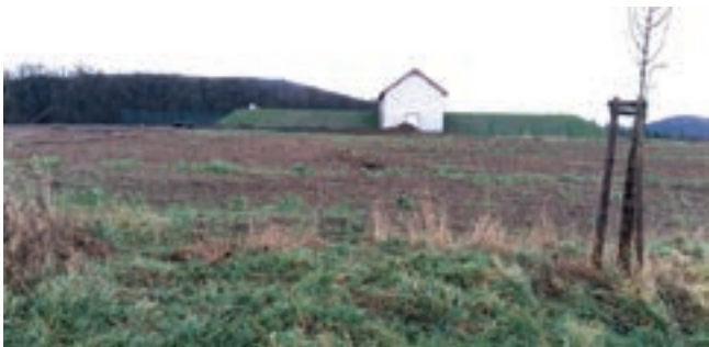
Obr. 11: Nový vodojem Podmračí II
