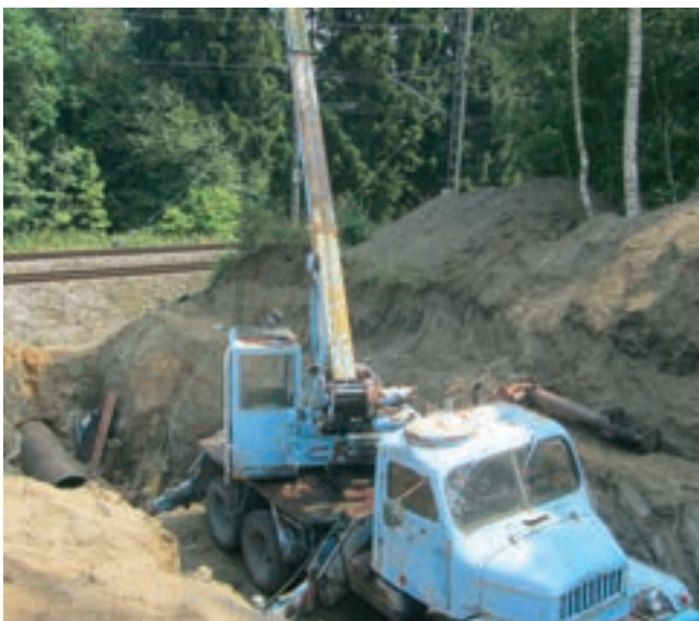
Obr. 5 a 6: Protlak pod železniční tratí Benešov u Prahy–Praha
