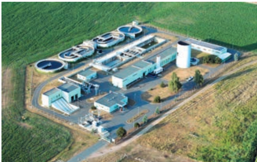
ČOV Bzenec po rekonstrukci
