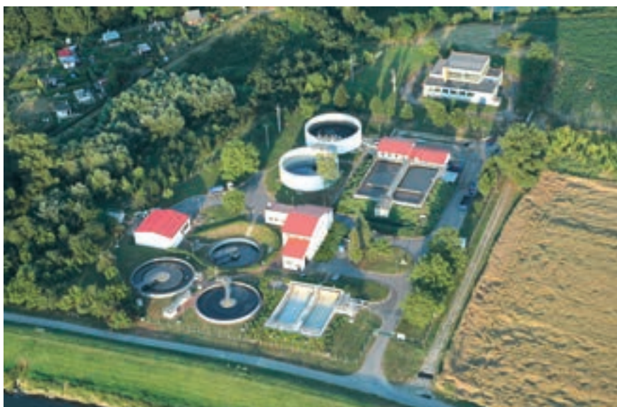
ČOV Veselí nad Moravou po rekonstrukci
