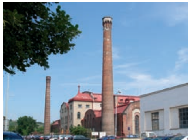
Průčelí budovy Lindleyho Staré čistírny
