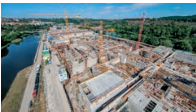
Příprava staveniště a staveniště
