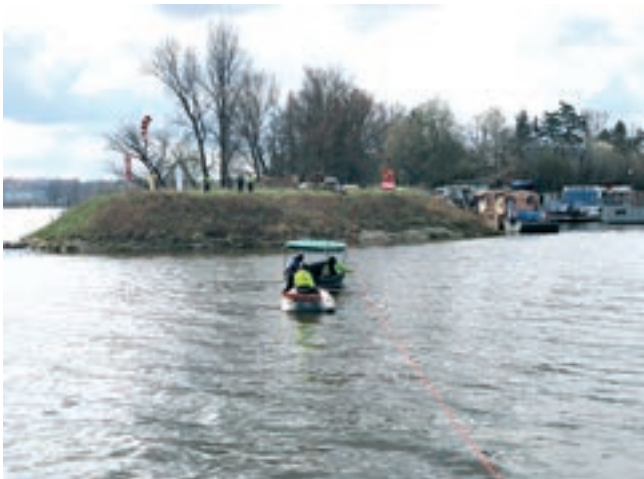
Navádění pilotního vrtu pod řekou Vltavou
