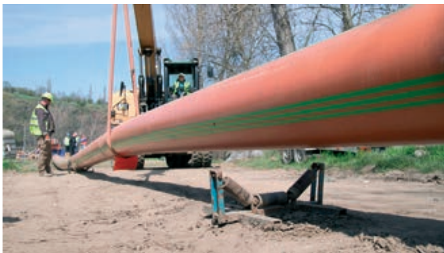
Příprava pro vtažení potrubí do vrtu
