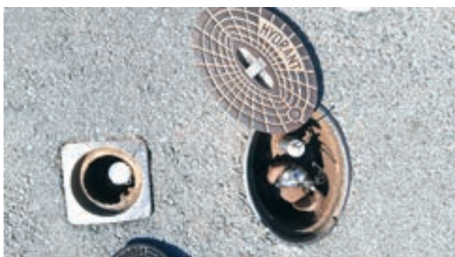
Osazení snímačů na místě v rámci měrné kampaně
