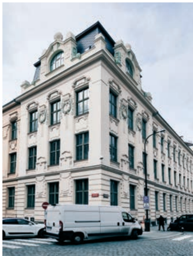
Obr. 3 a 4: Budova stavební fakulty ČVUT v Trojanově ulici
