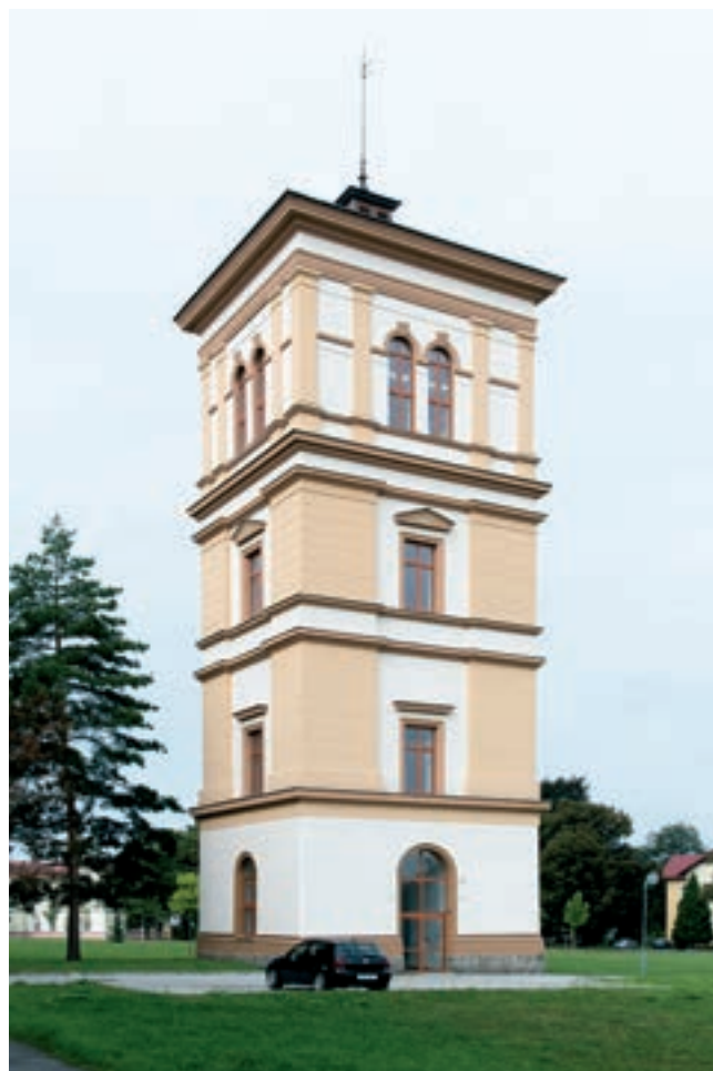
Obr. 3: Provozně specifickým areálem jsou například nemocnice a léčebny. Na snímku věžový vodojem psychiatrické nemocnice v Dobřanech, který je zároveň nejstarším evidovaným věžovým vodojemem postaveným mimo oblast železnice (vpravo)
