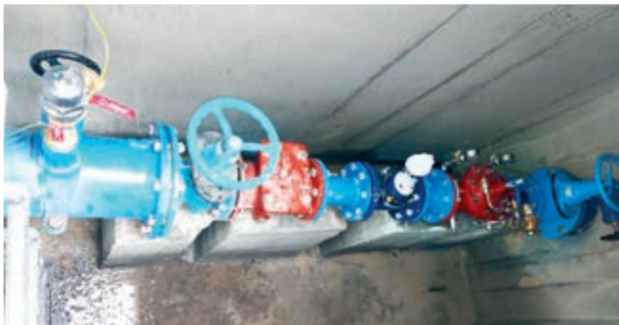
Obr. 3: Armaturní šachta na ulici Jubilejní park
