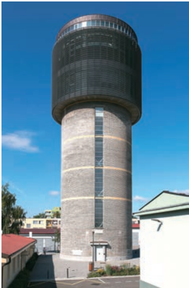
Obr. 8: Kladenský věžový vodojem prošel zdařilou a poměrně zásadní přestavbou a dnes slouží provozovateli vodárenské infrastruktury ke zcela novým účelům
