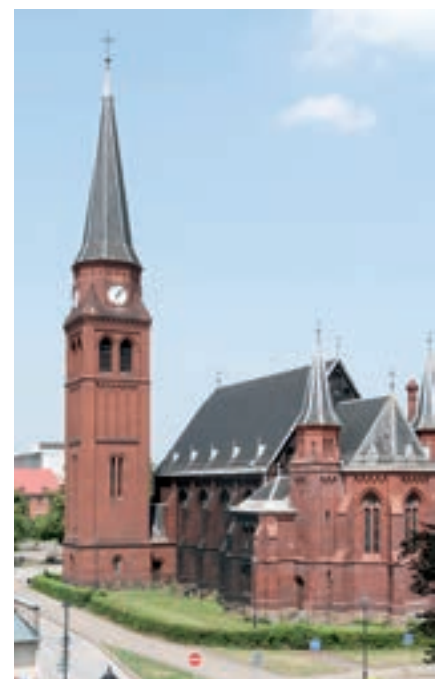
Obr. 6: K ojedinělému spojení funkce věžového vodojemu a zvonice kostela došlo v roce 1882 v tehdy samostatných Vítkovicích (dnes Ostrava-Vítkovice)
