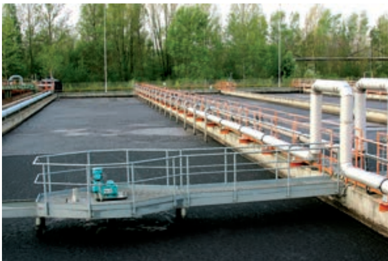
Obr. 1: Jedna z modernizovaných aktivačních nádrží
