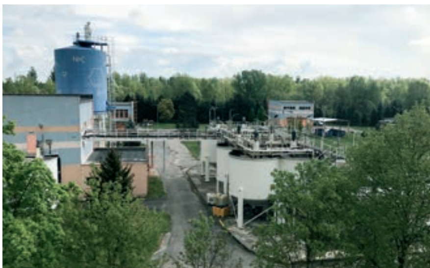
Obr. 2: Pohled na neutralizační linku – neutralizační reaktory a vápenné hospodářství
