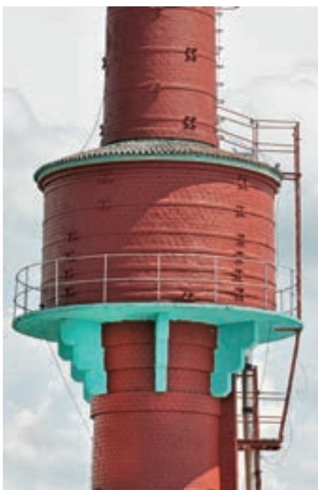
Obr. 5: Komínový vodojem nesený deskou podepřenou konzolami v bývalé Litovelské továrně poživatín Petr Hlaváček (rok výstavby 1917)
