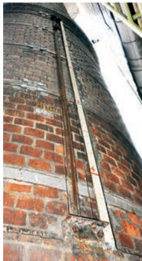
Obr. 11: Kovový stavoznak vodní hladiny u paty komína v bývalém ČKD Slaný
