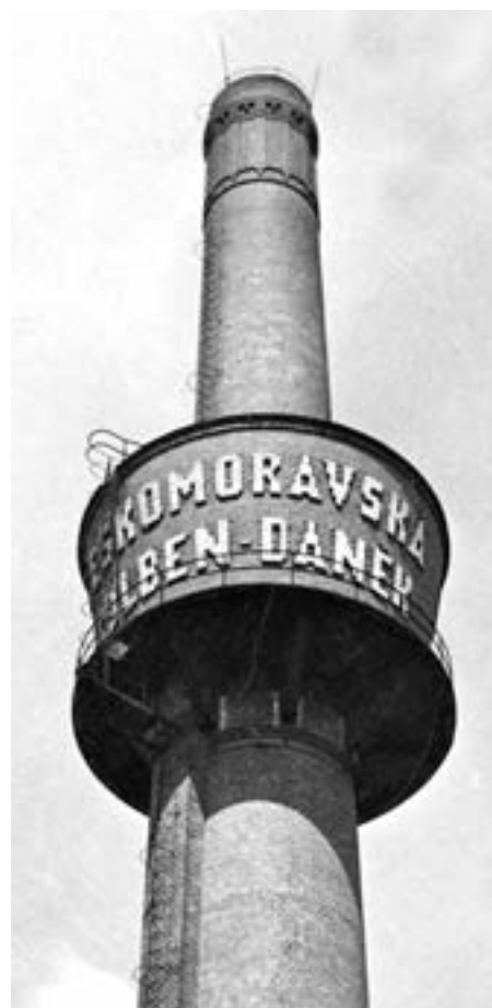
Obr. 7: Komínový vodojem se jménem firmy v areálu ČKD v Praze-Vysočanech
