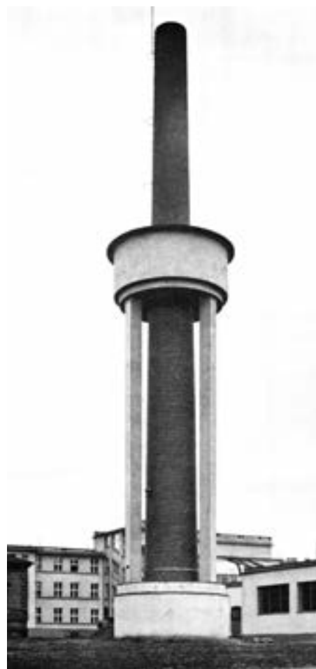
Obr. 10: Netradiční řešení vedení potrubí u komína v areálu pardubické nemocnice
