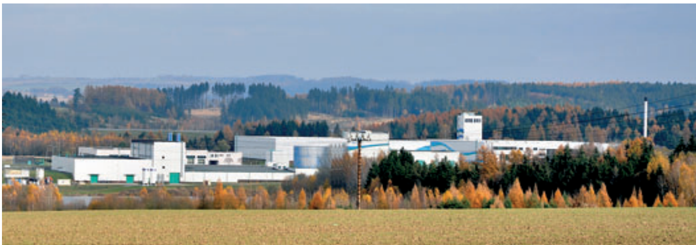
Pohled na úpravnu vody
