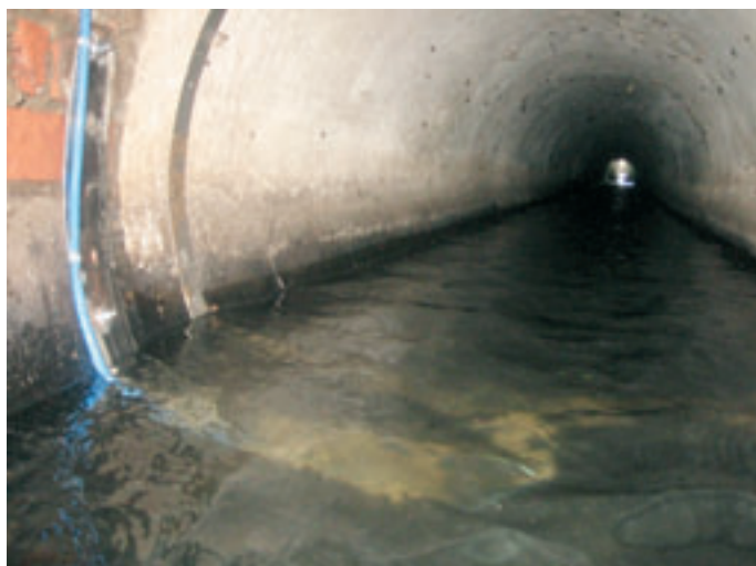
Obr. 3: Instalace v profilu DN 900 – odtok ČOV Miškovice
