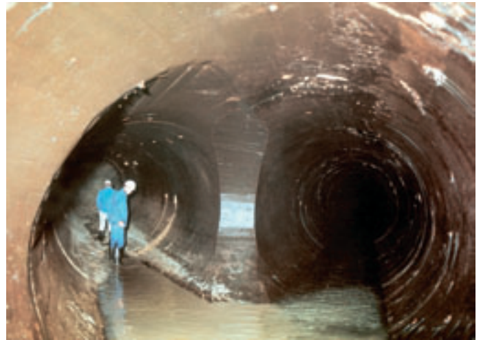
Štolový přivaděč k Želivce
