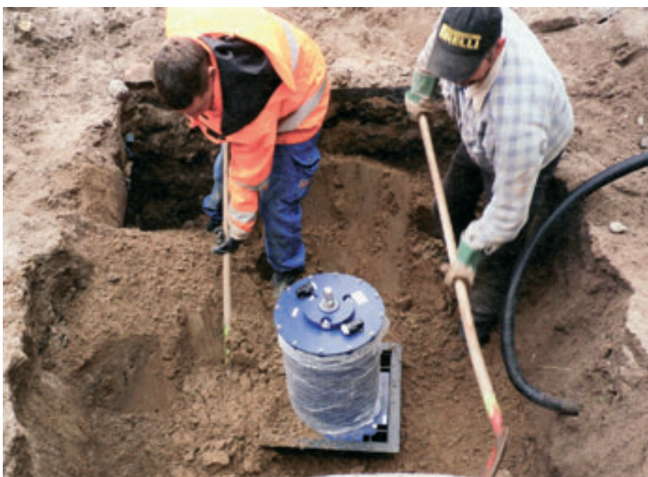
Obr. 4: Instalace pohonu armatury
