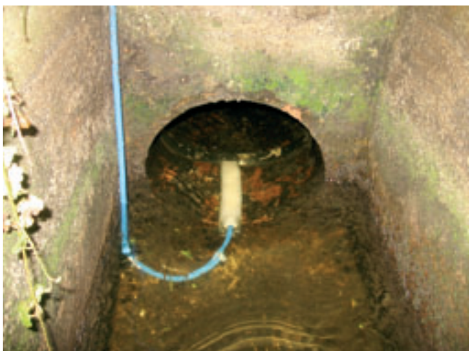
Obr. 2: Instalace v profilu DN 300 – odtok ČOV Vnoř
