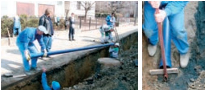
Intravilán: ruční manipulace, pokládka a jednoduchá montáž i ve složitých městských podmínkách
