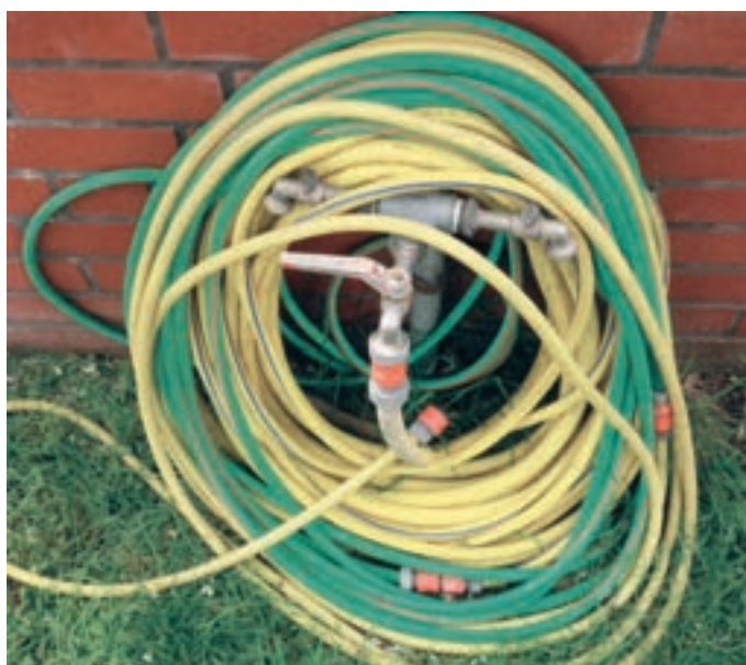
Obr. 4: Nejjednodušší způsob, jak může nežádoucí voda proniknout do rozvodů pitné vody, je přes výtokovou armaturu
