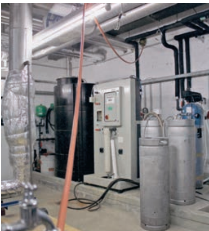
Obr. 2: Také konstrukce k napájení topné soustavy je nutné zajistit pomocí přerušovače průtoku
