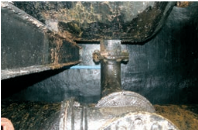
Obr. 2: Detail stavu původního vystrojení
