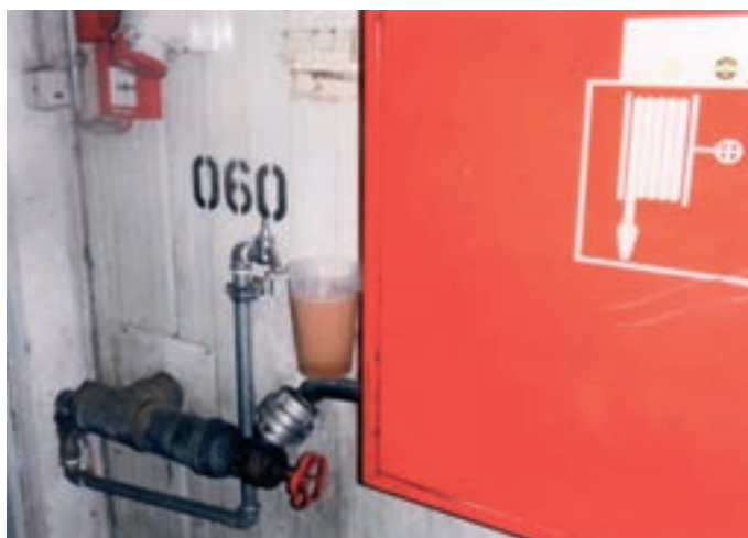
Obr. 3: Oddělení obou systémů volným výtokem. Nejsou-li dodrženy požadavky německého Nařízení o pitné vodě, nelze v případě rozvodů pitné vody, na něž jsou napojena hasicí a protipožární zařízení, obhájit původní způsob instalace.
