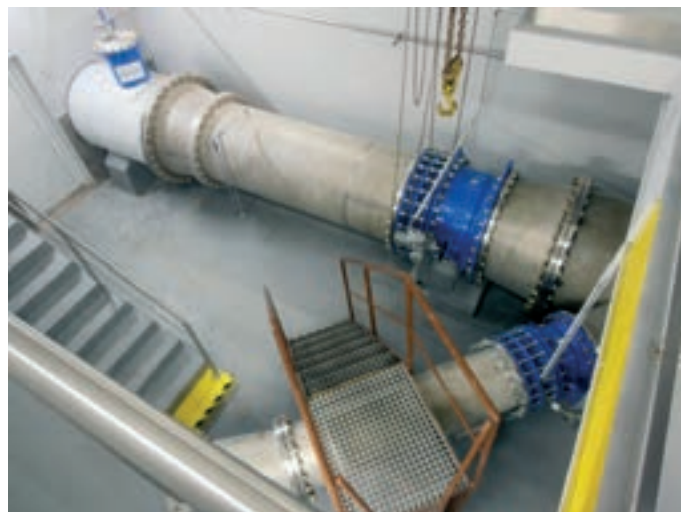
Obr. 10: Po rekonstrukci, pohled z přízemí do suterénu
