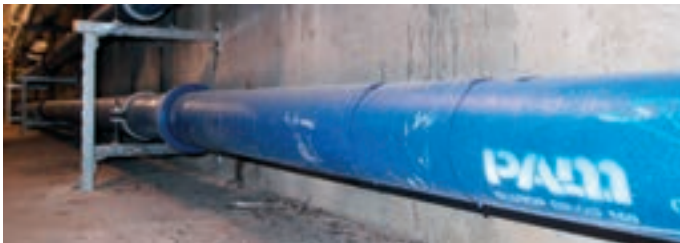
Speciální aplikace: rozvodné řady v kolektorech
