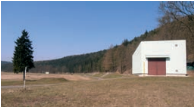
Obr. 1: Celkový pohled na evakuační stanici, jímací štolu a sběrnou studnu
