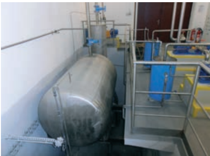
Obr. 3: Nová podtlaková nádoba s vývěvami
