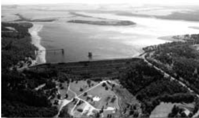
Obr. 2: Vodní dílo Přísečnice – letecký pohled
