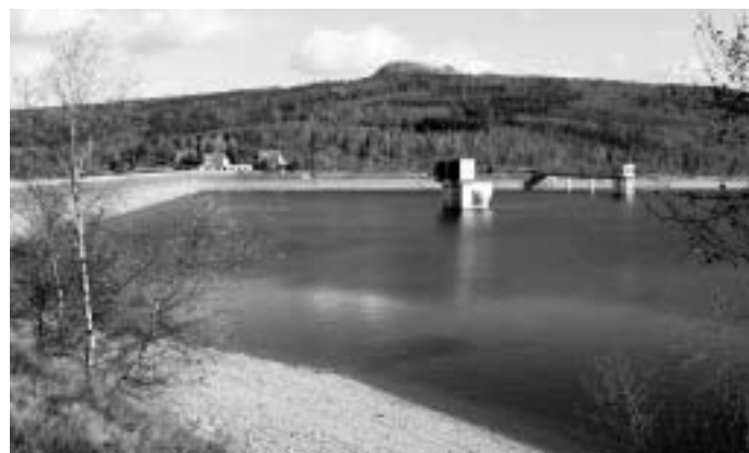
Obr. 3: Vodní dílo Přísečnice – hráz
