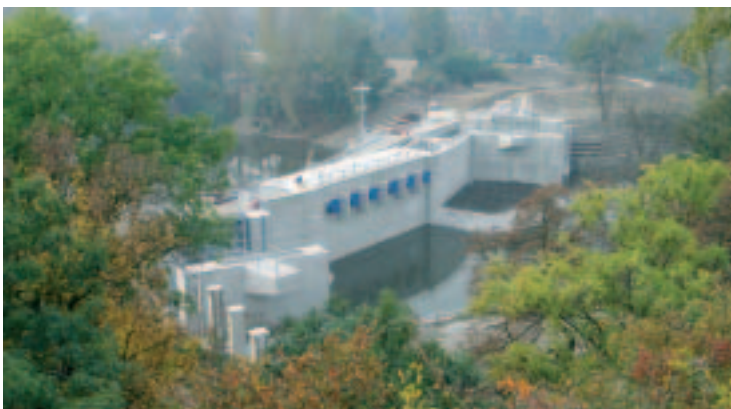
č. 32 Libeňské přístavy – povodňová čerpací stanice a část č. 33 Libeňské přístavy – protipovodňový uzávěr přístavů.
