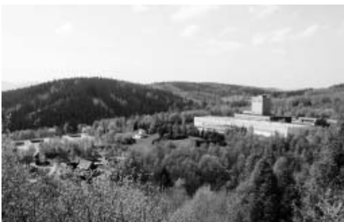
Obr. 6: ÚV Hradiště – celkový pohled
