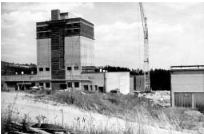
Obr. 5: Výstavba ÚV Hradiště
