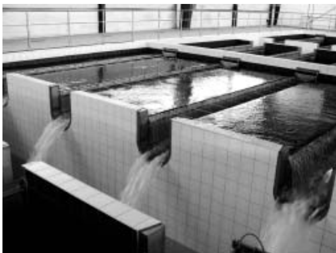
Obr. 8: ÚV Hradiště – rekonstruovaná filtrace (praní filtrů)
