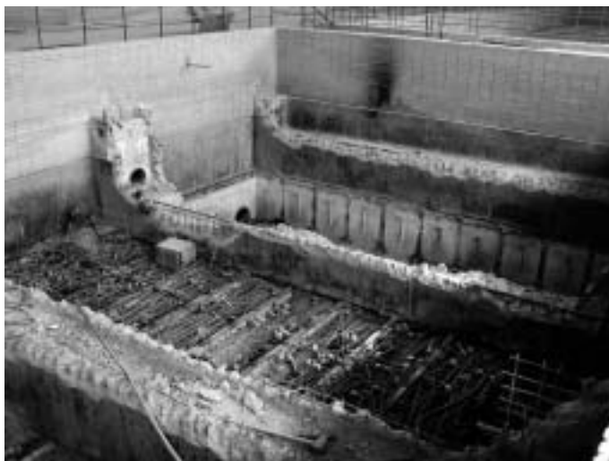
Obr. 7: ÚV Hradiště – demolice starých železobetonových konstrukcí filtrace
