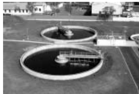
ČOV Žatec – dosazovací nádrže
