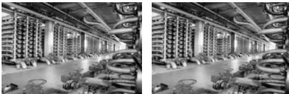
Obr. 4: Nanofiltrační zařízení v úpravně Méry sur Oise
