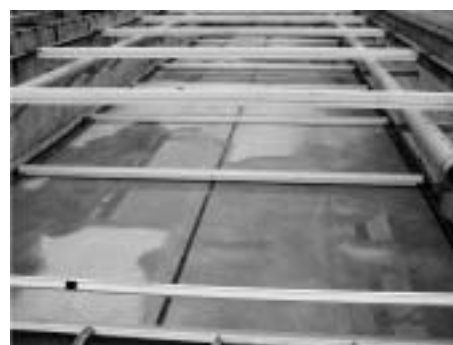
ČOV Jirkov – dosazovací nádrž
