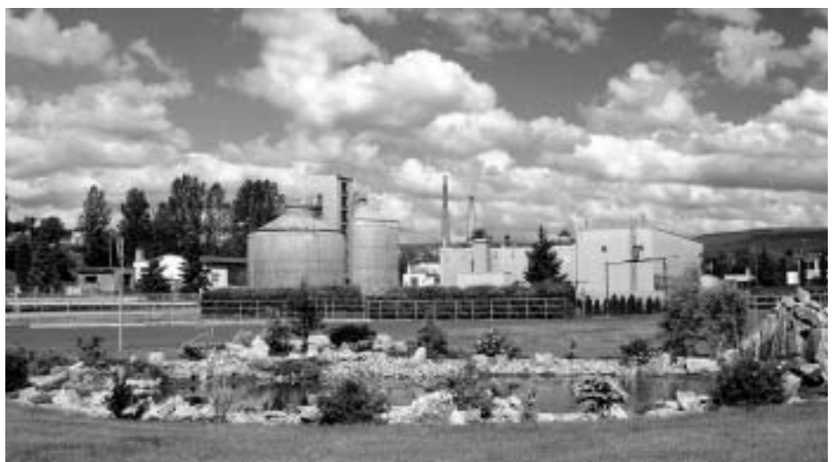
ČOV Bystřany – Teplice
