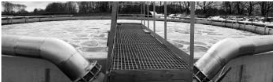
ČOV Údlice – nitrifikace ve stávající kruhové dosazovací nádrži
