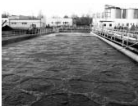
ČOV Jirkov – nitrifikace
