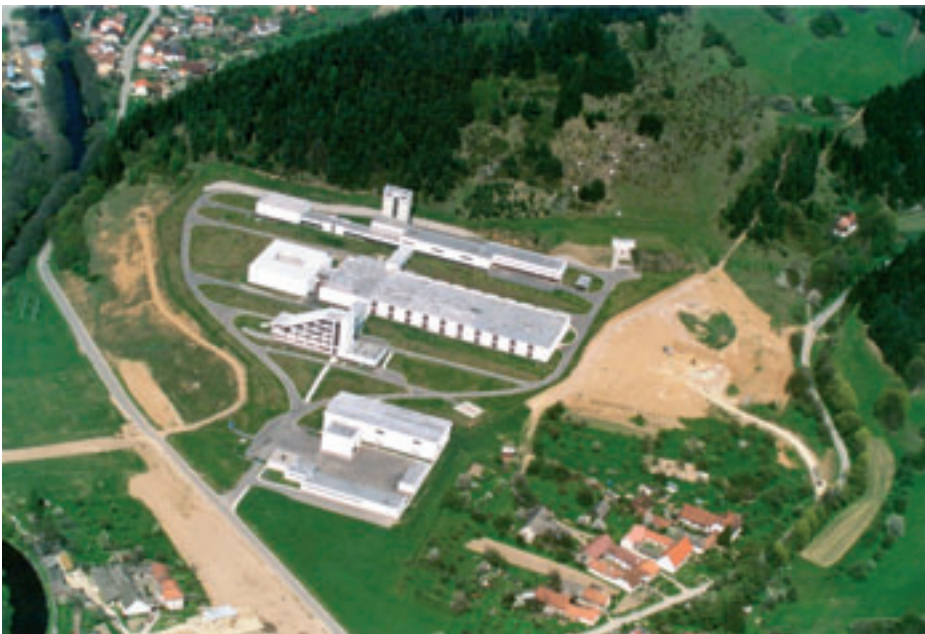
Úpravna vody Švařec
