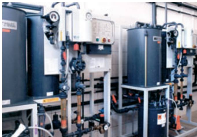
Technologické zařízení na výrobu oxidu chloričitého
