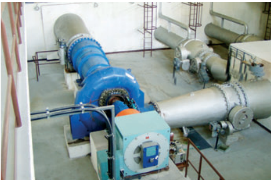
Přítok surové vody s turbínou
