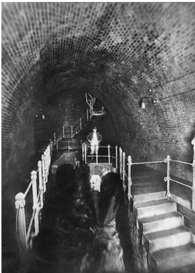
Spojná komora sběračů I a II se stokou A, 1911
