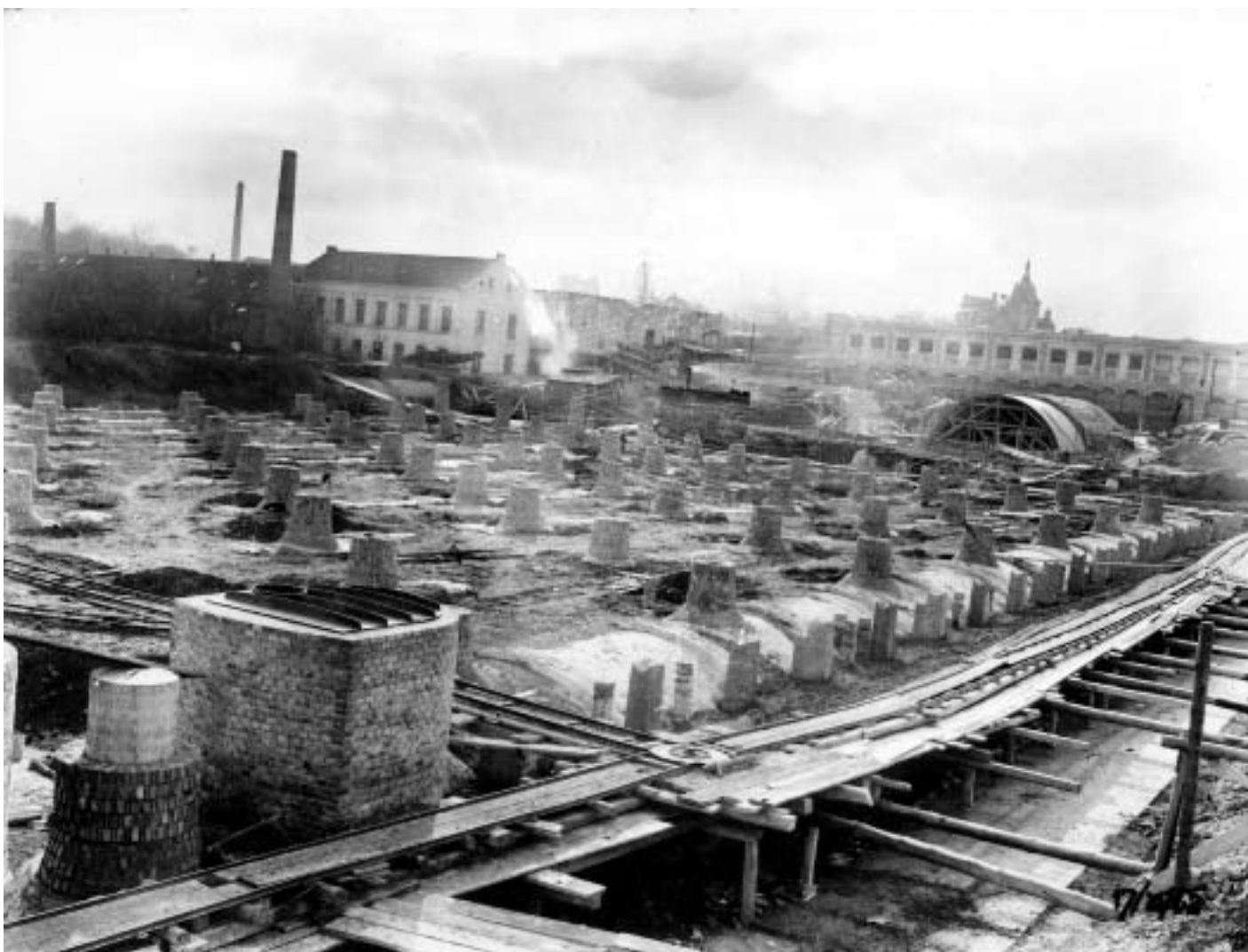
Celkový pohled na staveniště čistírny, 17. 11. 1902
