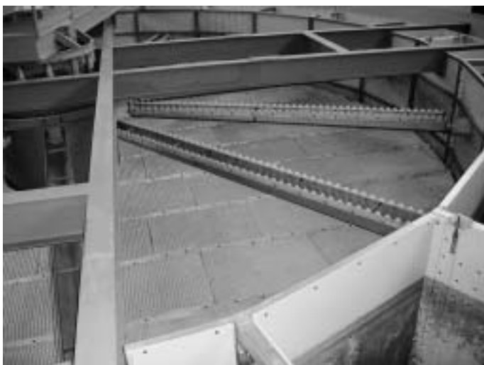
Obr. 4, 5: Usazovák s obvodovým mezikružím pro pomalé míchání, vystrojený a nezasypaný filtr
