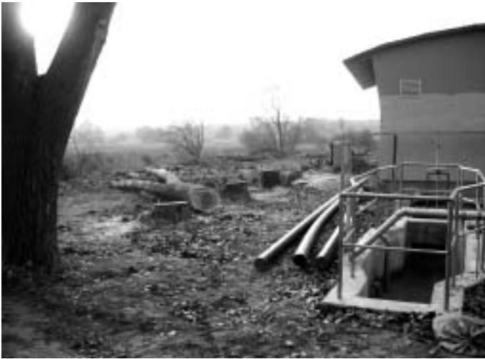
Kácení stromů při rekonstrukci ČOV
