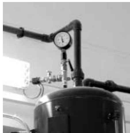
Obr. 2: Snímač podtlaku instalovaný na odbočce k manometru
