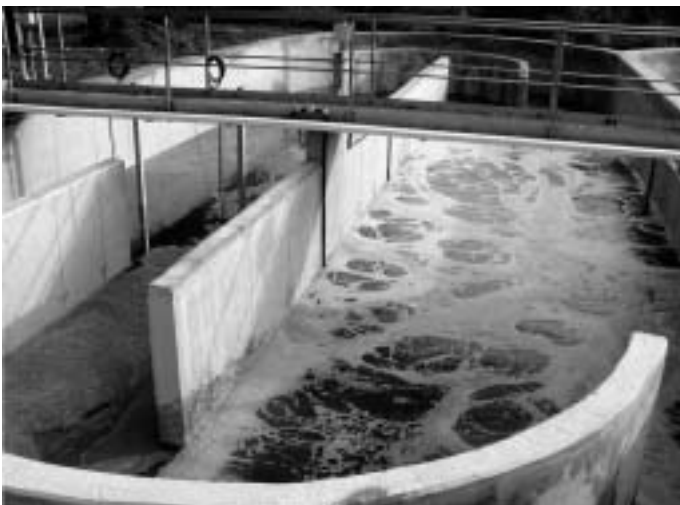
Nová aktivační nádrž při napouštění
