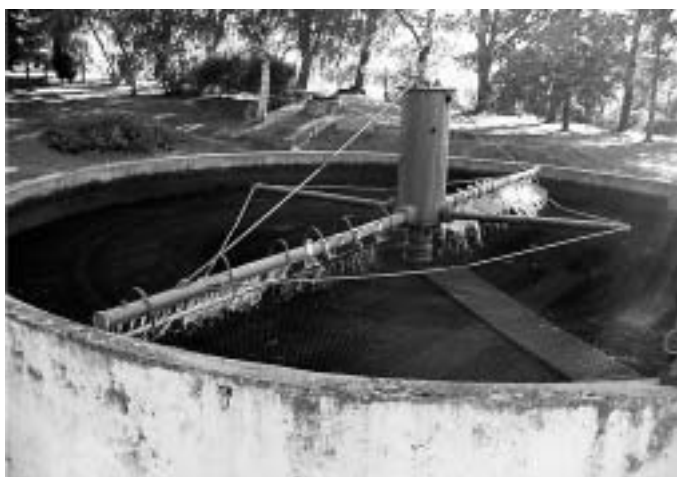
Původní biofiltr – pravý
