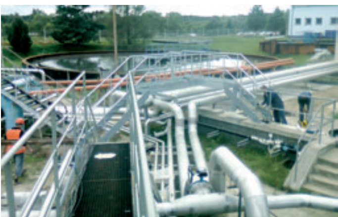
ČOV Mariánské Lázně – výstavba rozvodů vzduchu a kalů, pohled na levou biologickou linku
