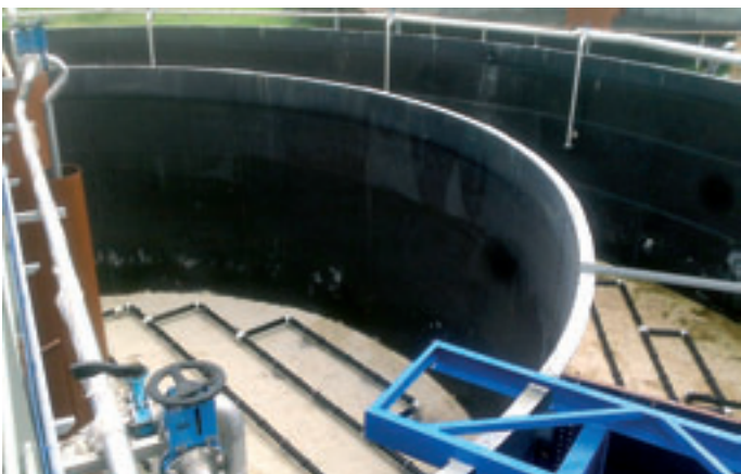
ČOV Mariánské Lázně – pohled na objekt rekonstruované aktivace levé biologické linky
