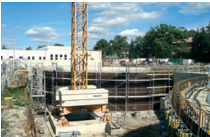
Výstavba nových kruhových dosazovacích nádrží ČOV Cheb
