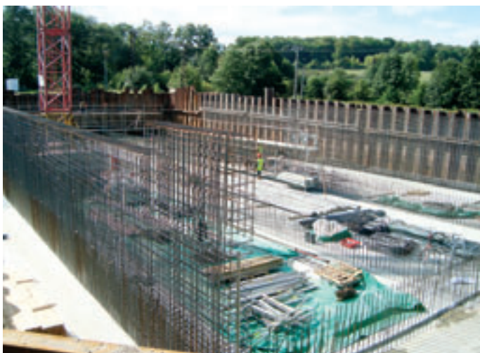
Výstavba dešťové zdrže ČOV Cheb
