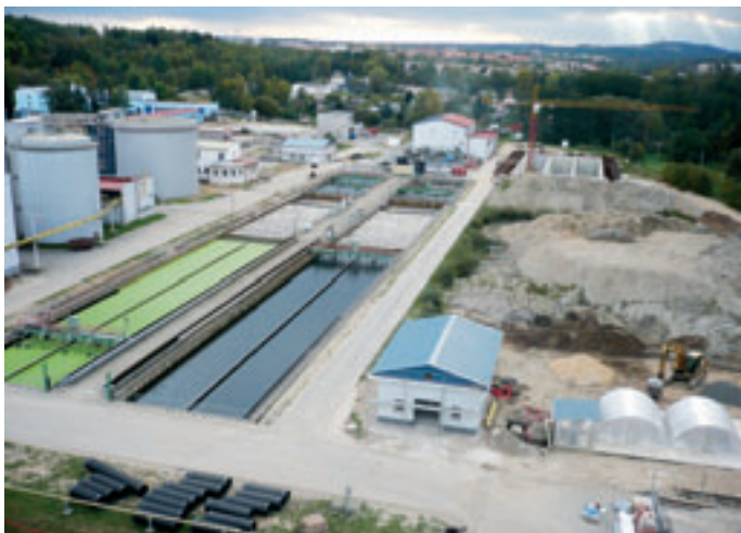
Pohled na část rekonstruovaného areálu stávající ČOV Cheb
