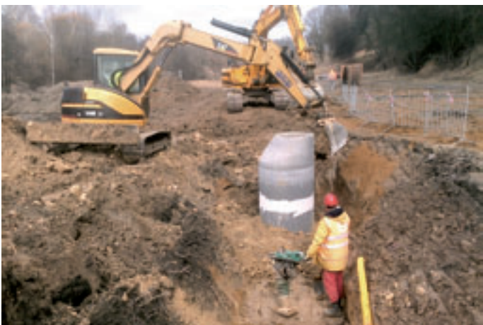
Pohled na výkopové práce pro odkalizování městské části Chebu – Švédského vrchu
