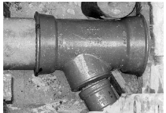
Realizace systému GRAVITAL v ČR – stavba kanalizace DN 300 Třemošná, stavební firma STAVAS, spol. s r. o.
