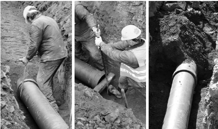
První realizace systému GRAVITAL v ČR - stavba kanalizace DN 300 Praha – Radotín, stavební firma ZEPRIS, spol. s r. o.
