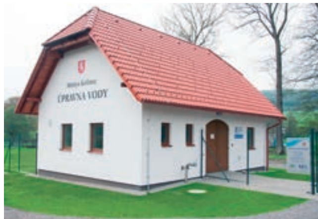
Úpravna vody Kolinec
