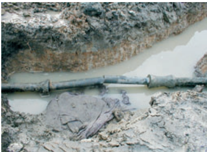
Obr. 2: Příklad rizika vniknutí kontaminujících látek do distribučního systému [5]
