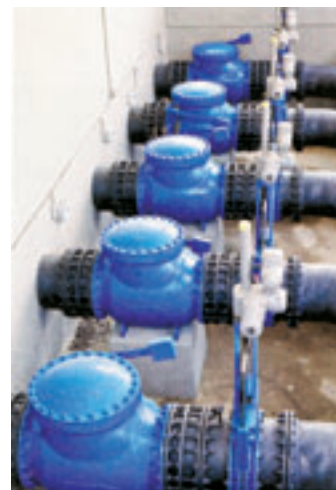
Obr. 4: Manipulační komora s výpustnými ventily na přečerpací stanici městských odpadních vod, společnost Aguas de Cartagena, Kolumbie
