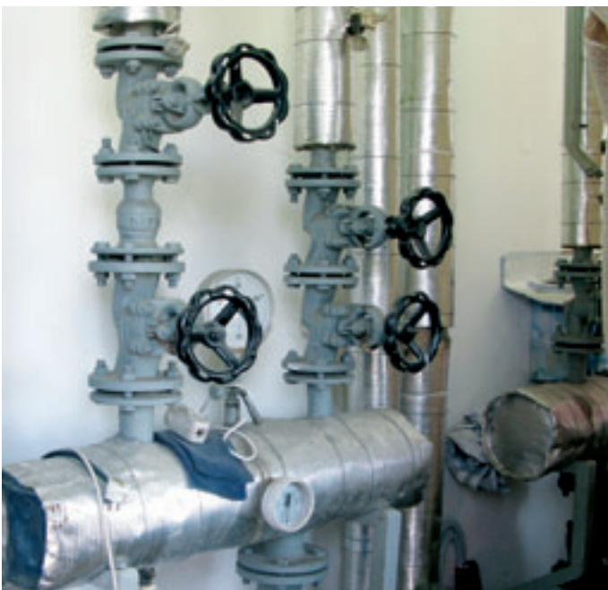
Obr. 4: Pohled na napojovací místo provozní budovy
