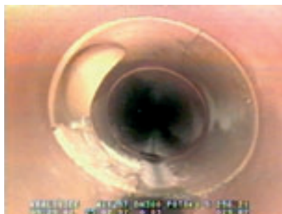
Obr. 7: Deformace plastových trub
