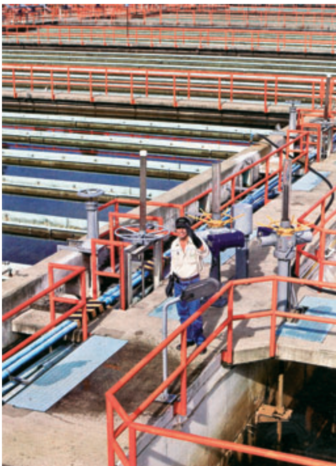
Obr. 1: Usazovací nádrže na úpravě vody v Manatiales v Medellinu v Kolumbii (Foto Christopher Jennings)
