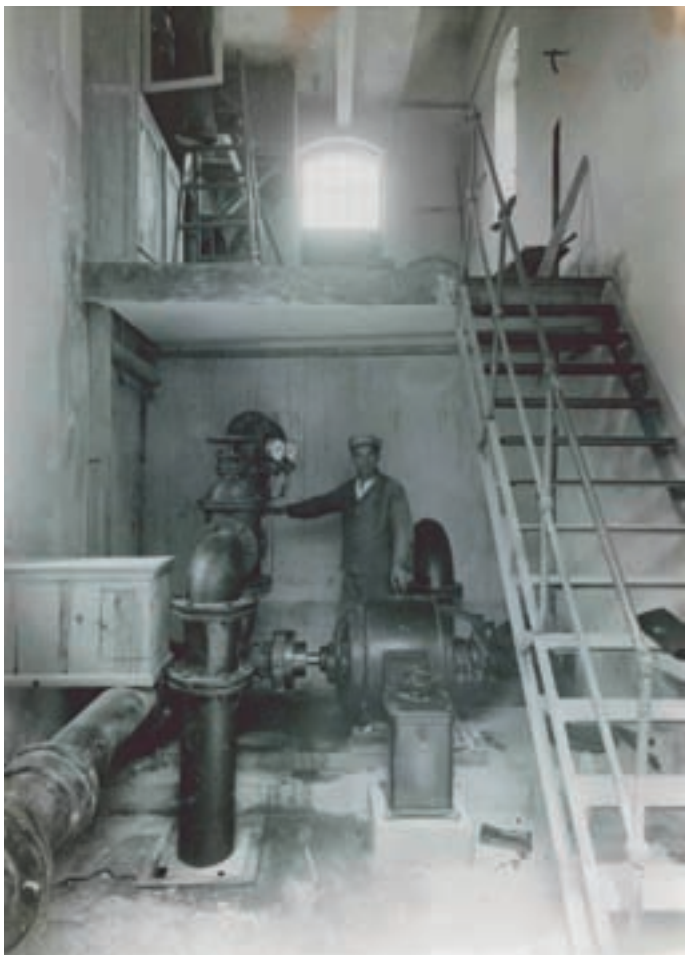
1878 – zprovoznění strojovny pro čerpání užitkové vody z řeky Dyje do Znojma od Obřích hlavy
