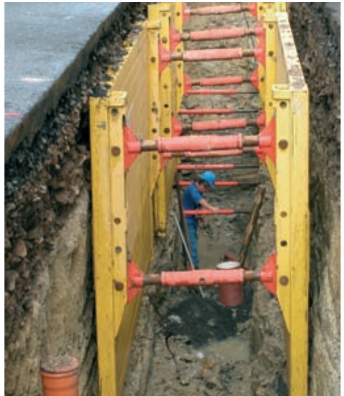
Práce na odkanalizování v aglomeraci Duchcov (finanční objem 105 mil. Kč)
