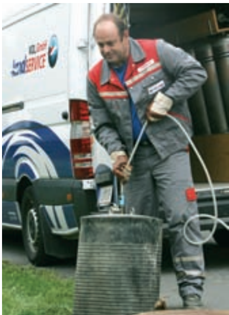
Foto 6: Tlakové zkoušky vodotěsnosti kanalizační sítě jsou v Rakousku prováděny nezávislými firmami a podmínky jejich provádění přesně stanovují zákonné předpisy. Běžný je rovněž dvojitý systém kontroly stavu kanalizačního potrubí a to tlakovými zkouškami i kamerovým monitoringem. Majitelům kanalizační infrastruktury šetří zkoušky náklady při provádění oprav, jsou podkladem při reklamačním řízení a kolaudačního řízení při přejímání novostaveb.
