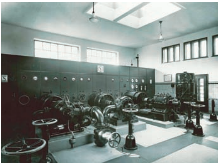
1935 – dokončená nová strojovna čerpací stanice U Obří hlavy s čerpadly na 50–60 l/sec k čerpání užitkové vody z řeky Dyje do Znojma
