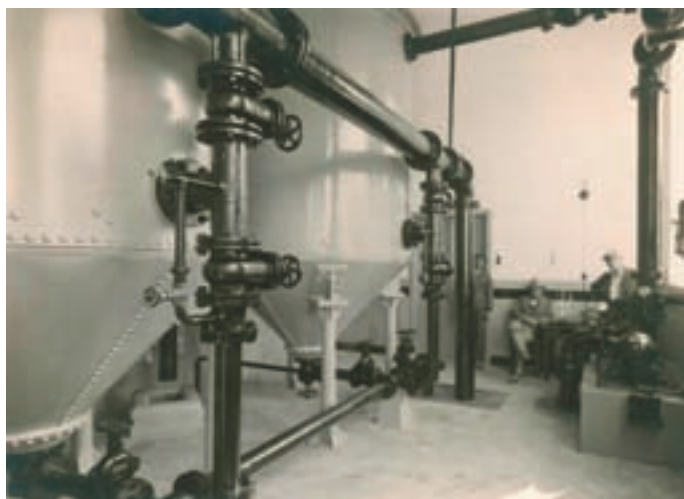
1930 – nová filtrační jednotka rychlofiltru „DABEG“ na užitkovou vodu z řeky Dyje od Obřích hlavy
