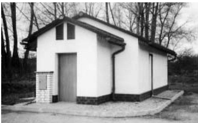
Obr. 1: Původní podtlaková stanice
