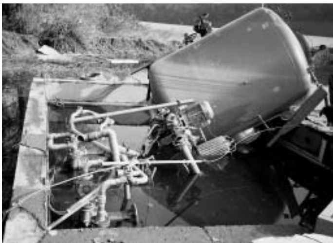
Obr. 2: Původní podtlaková stanice – po povodni v r. 2002
