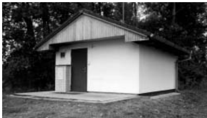
Obr. 3: Nová podtlaková stanice
