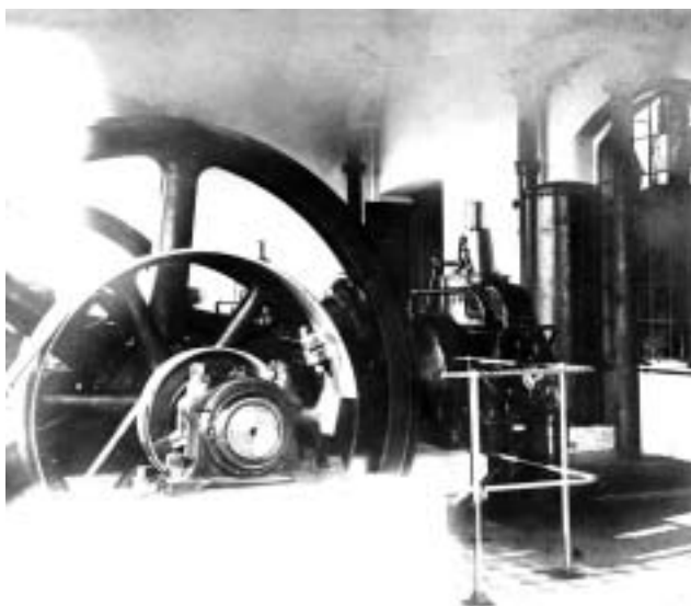
Čerpací stanice v Braníku (motory na nasávaný plyn), 1907
