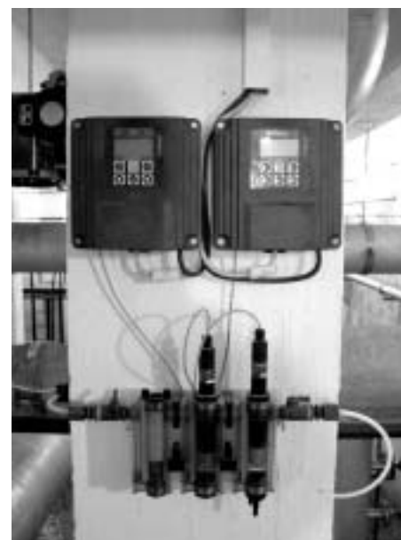
Obr. 8: Snímač zákálu prací vody. Sestava s mechanismem umožňujícím kontroly a čištění za provozu. Prioritní ukončení regenerace filtrů.
