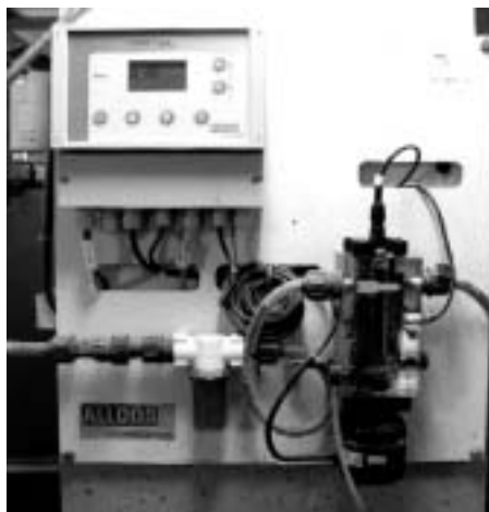
Obr. 6: Analyzátor ozónu ve vodě. Přívod vzorku vody přes filtr, průtočný blok s mechanickým stíráním čidla. Signál pro přímé omezení výkonu ozonizátoru
