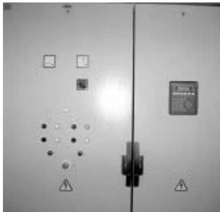
Obr. 4 a 5 (nahore a vpravo): Pohled na podružný rozváděč technologie. Pole silových prvků a pole MAR a ASŘ včetně místního ovládacího panelu
