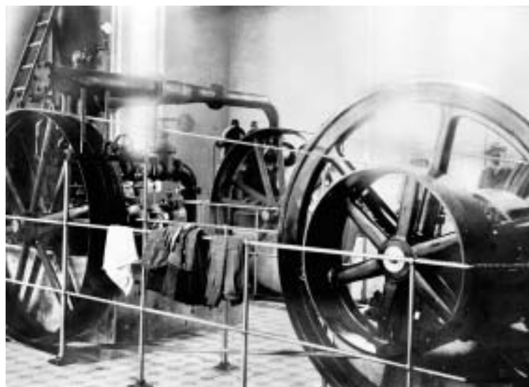
Strojní zařízení čerpací stanice na Zelené Lišce, 1907
