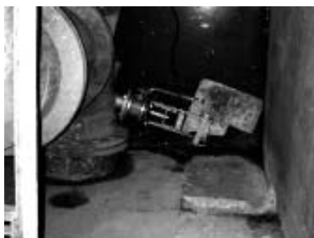
Obr. 8: Snímač zákálu prací vody. Sestava s mechanismem umožňujícím kontroly a čištění za provozu. Prioritní ukončení regenerace filtrů.
