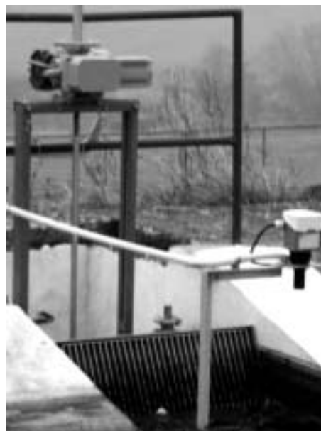
Obr. 10: Kalové hospodářství. Měření hladiny ultrazvukem a akční člen, přestavitelné hradítko se servopohonem. Programové řízení odsazování prací vody a její vypouštění a přečerpávání
