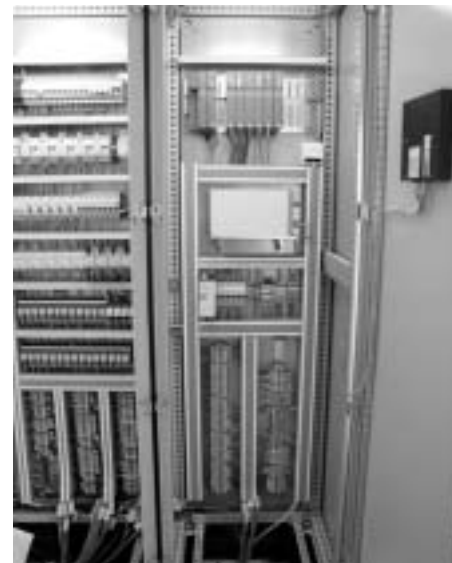
Obr. 4 a 5 (nahore a vpravo): Pohled na podružný rozváděč technologie. Pole silových prvků a pole MAR a ASŘ včetně místního ovládacího panelu
