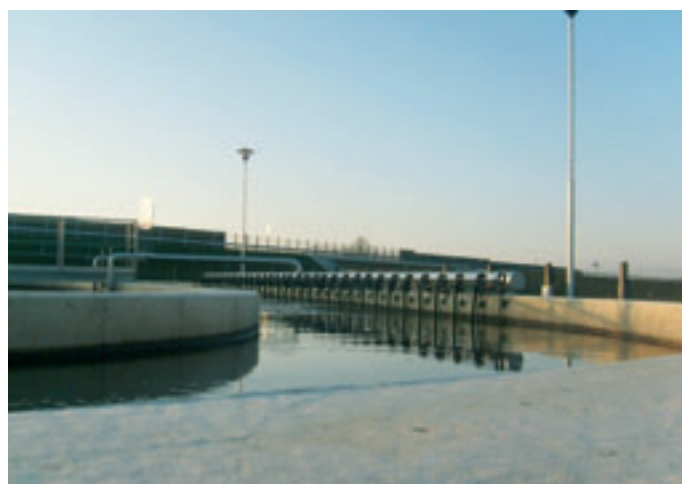
ČOV Holice – objekt biologického čištění
