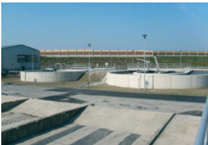
ČOV Holice – dosazovací nádrže
