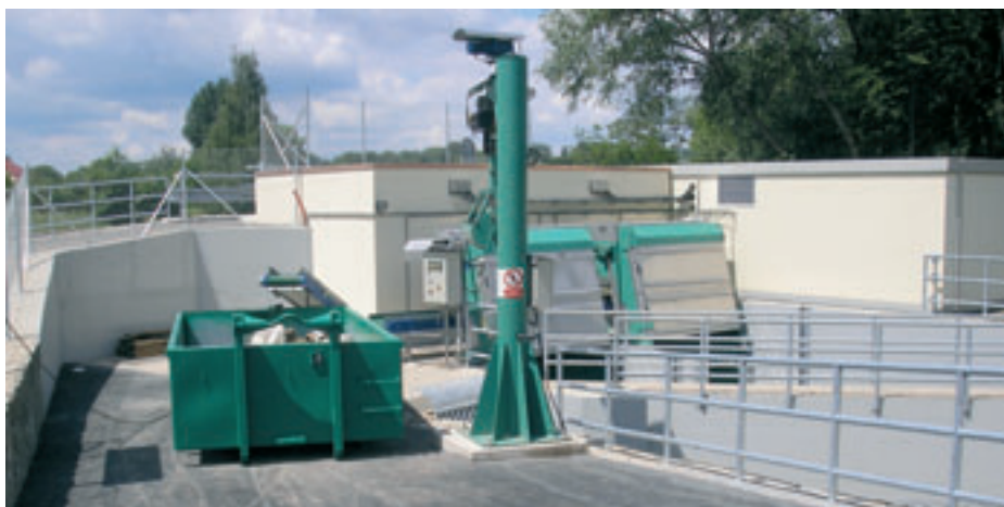
Čerpací stanice Spojský odpad
