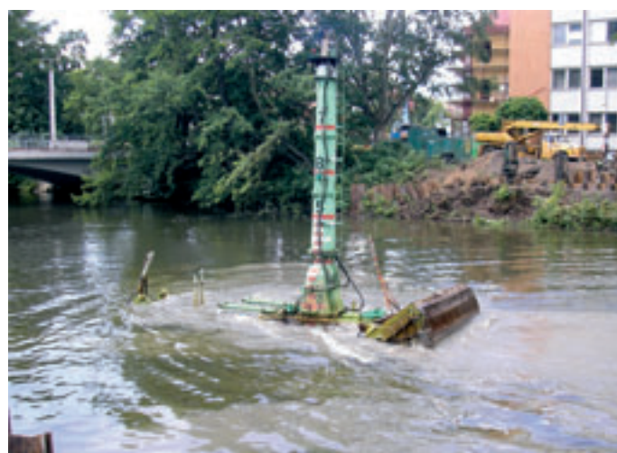
Hloubení rýhy ve dně Chrudimky pro uložení shybky podvodním dozezem Komatsu
