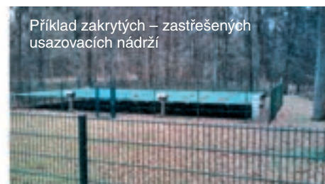
Obr. 2: Zamezení vnosu rušivých látek zastřešením otevřených usazovacích nádrží
