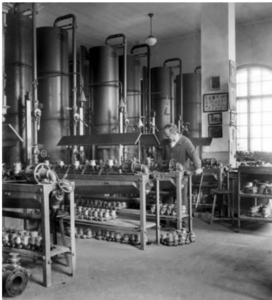
Interiér zkušebny vodoměrů ve Vinohradské vodárně, 22. 5. 1956. Archiv PVK
