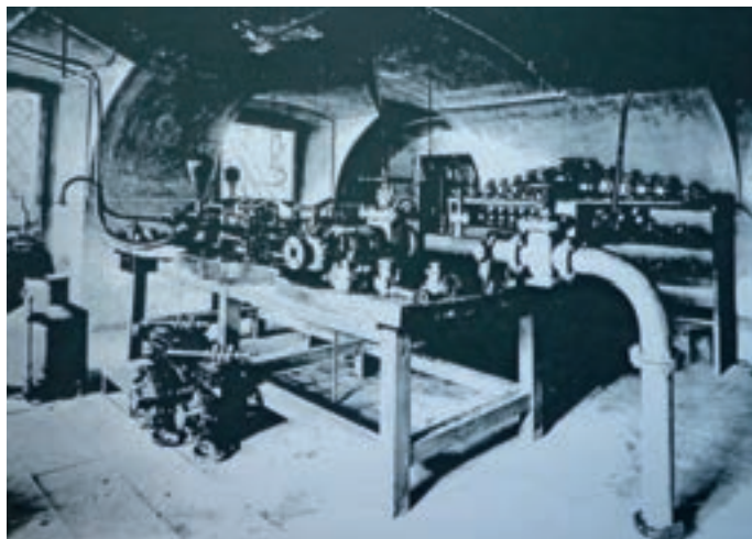
Interiér zkušebny vodoměrů v Novomlýnské vodárně v roce 1886. Archiv PVK
