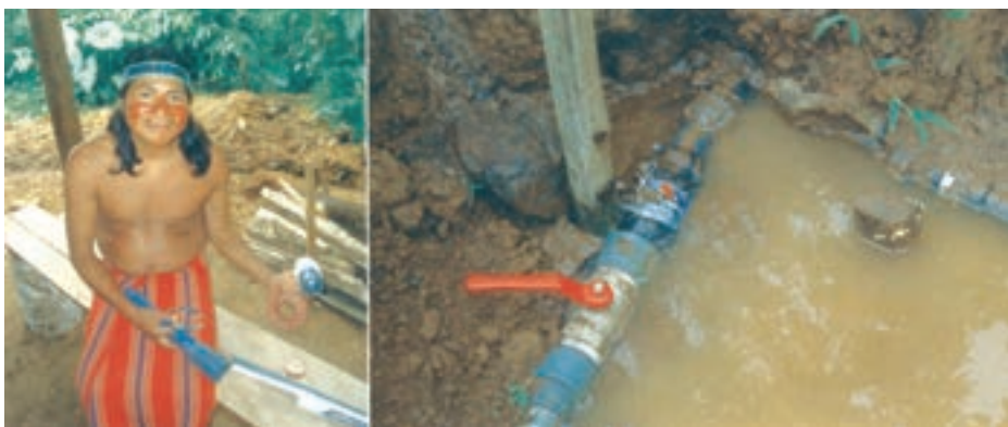
Obr. 2: Pověřelec – zmocněnec pro vodu Fernando s částmi potrubí (vlevo) a zabudovaný uzavírací kohout (vpravo)
