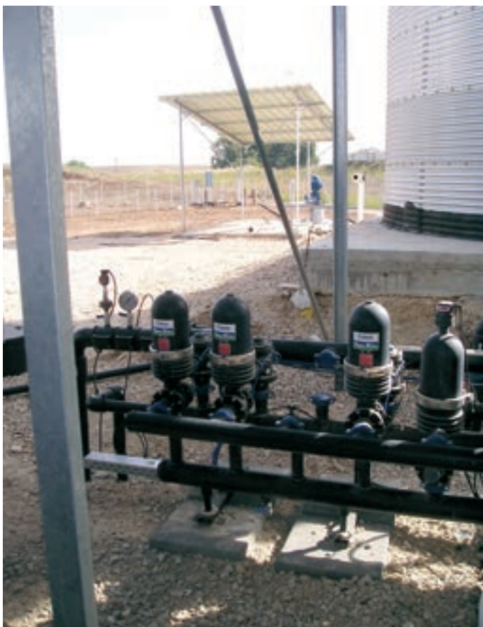
Obr. 1: Filtrační jednotky výrobní linky na „ultračistou vodu“ – v pozadí nádrž na přebytečnou vodu předanou na závlahu. Okolí svědčí o umístění technologie v naprosto nekulturní, pouštní krajině.
