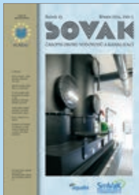
Titulní strana: ÚV Vyšň Lhoty, neutralizační stanice. Severomoravské vodovody a kanalizace Ostrava a. s.
