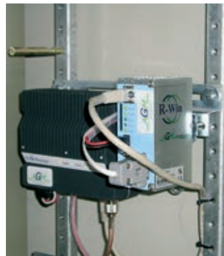
Obr. 9: Řídicí jednotka rozdělování závlahových vod a kontroly a redukce tlaků v potrubí rozvodů závlah
