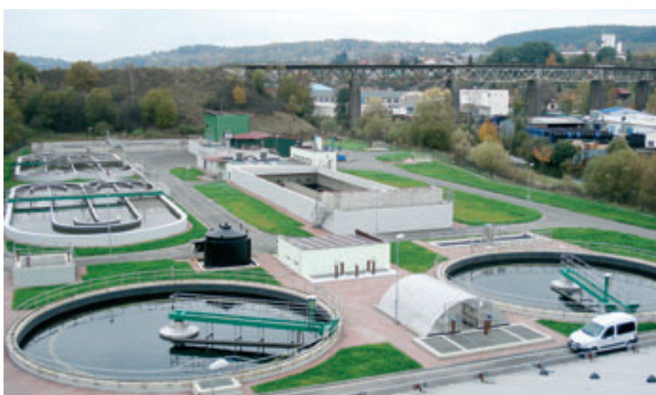
Pohled na ČOV
