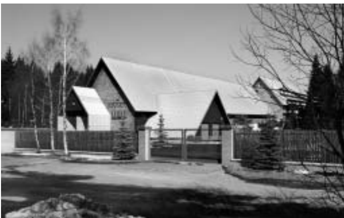
ÚV Souš po rekonstrukci
