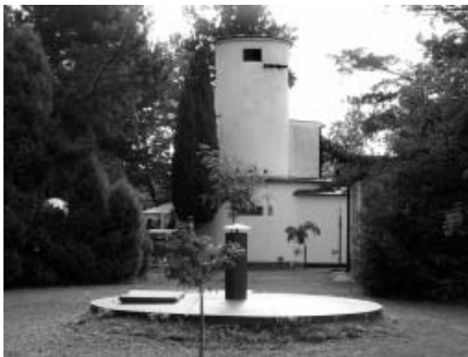
Objekt čerpací stanice Drnovice, září 2005
