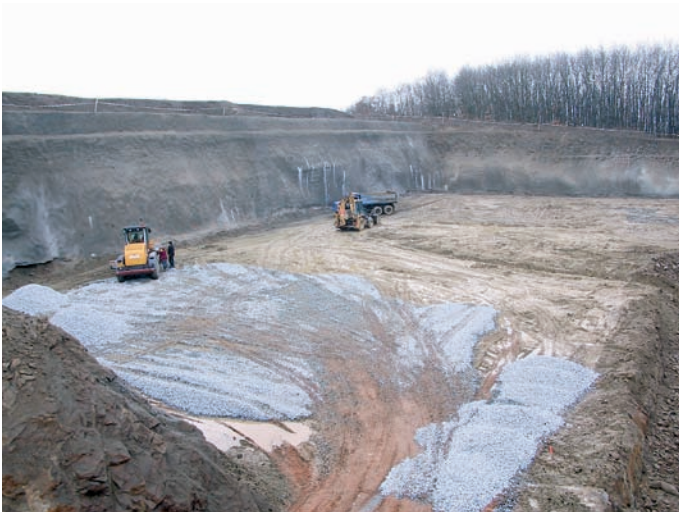
Obr. 5: Stavební jáma VDJ Lobzy
