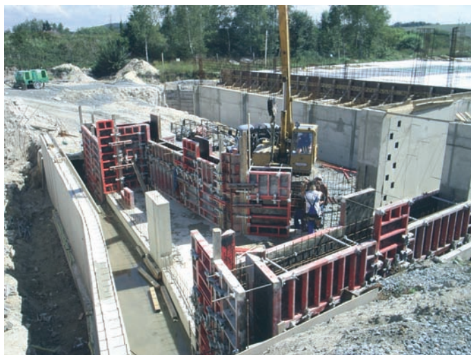
Obr. 4: Betonáž rozdělovací komory u RN Bolevec
