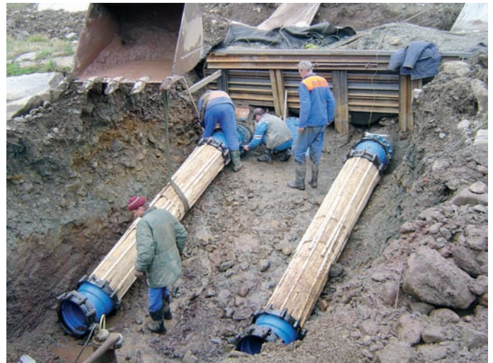
Obr. 7: Pokládka shybky přes Úslavu
