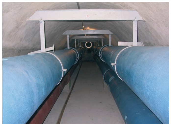
Obr. 8: Vystrojená štola VS Vinice
