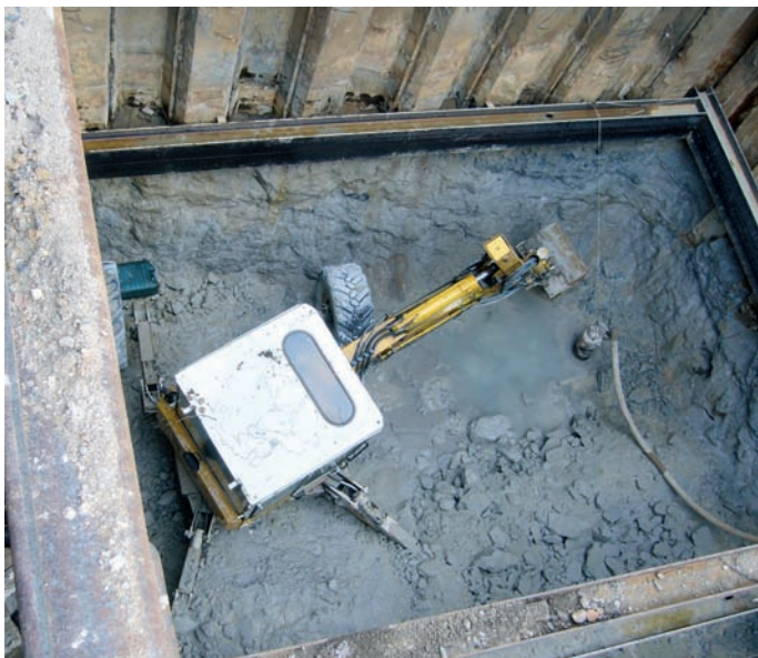
Obr. 2: Stavební jáma ČS OV Na Pořičí
