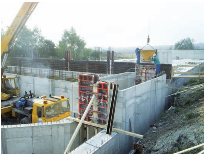
Obr. 3: Betonáž RN Bolevec
