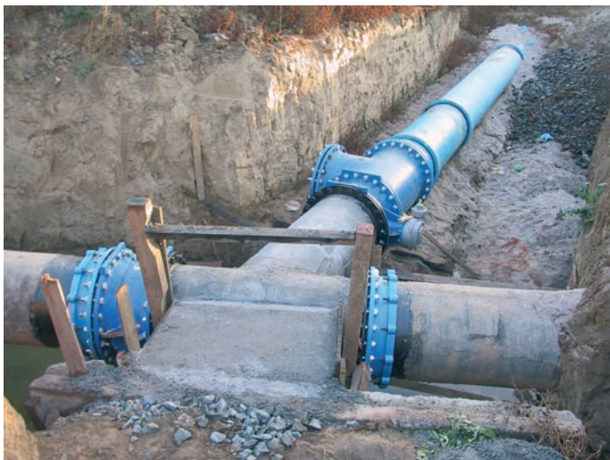
Obr. 9: Napojení na výtlač DN 700
