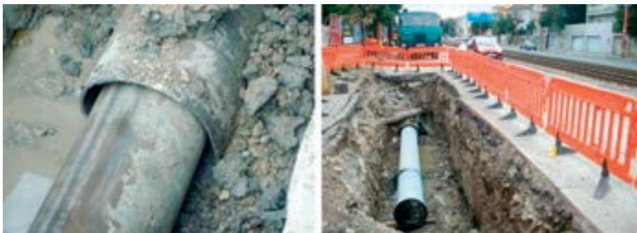
Berstringing, obnova stávajícího ocelového potrubí větší jmenovité světlosti DN 500 a DN 600 potrubím z tvárné litiny stejné jmenovité světlosti
