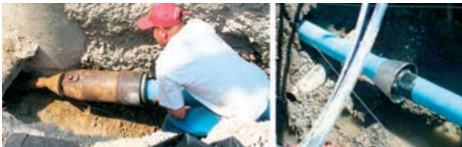
Berstringing: obnova stávajících potrubí malých jmenovitých světlostí potrubí z tvárné litiny
