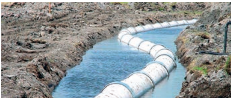
Horizontální vrtání: příklad pružnosti hrdlových spojů a snížení hmotnosti smontovaného potrubí velkých jmenovitých světlostí zatopením rýhy
