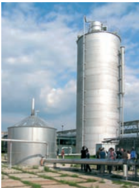
Obr. 8: Průmyslový IC reaktor
