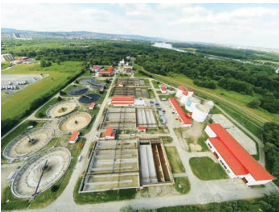
Letecký pohľad na ČOV Bratislava-Petržalka
