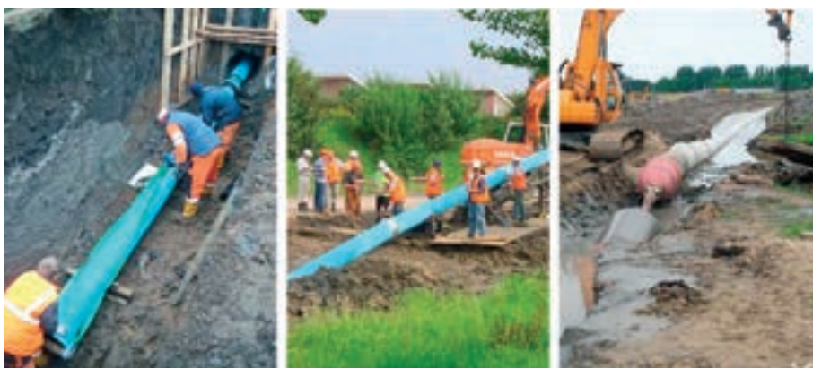
Horizontální vrtání: příklad montáže jednotlivých trubek, sestav 3 trubek a celého úseku
