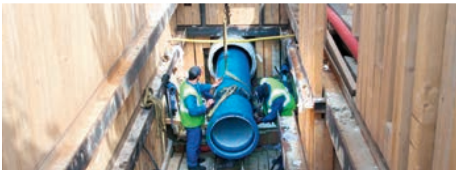
Relining: zatažení potrubí z tvárné litiny do stávajícího betonového potrubí
