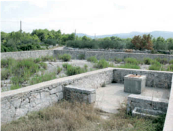
Obr. 2: Opuštěné „kišnice“ – sběrné plochy s podzemní cisternou na ostrově Hvar
