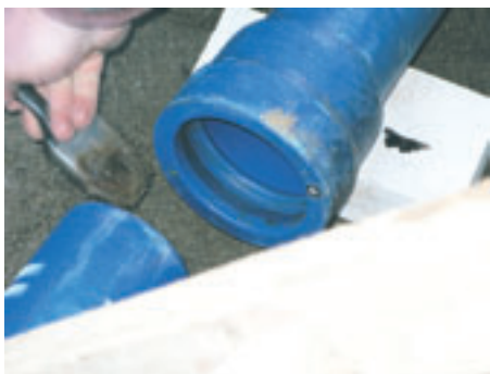
Projekt Sedlčany – krok 1 – namazání vnitřku hrdla mazací pastou a nasazení těsnícího kroužku do hrdla
