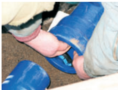
Projekt Sedlčany – krok 1 – namazání vnitřku hrdla mazací pastou a nasazení těsnícího kroužku do hrdla
