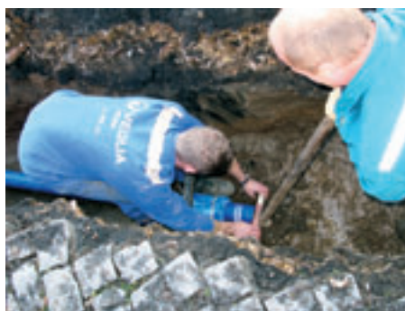
Projekt Sedlčany – krok 3 – ruční montáž pomocí tyče a konečné překrytí smontovaného spoje manžetou
