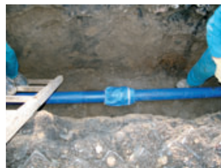
Projekt Sedlčany – krok 3 – ruční montáž pomocí tyče a konečné překrytí smontovaného spoje manžetou
