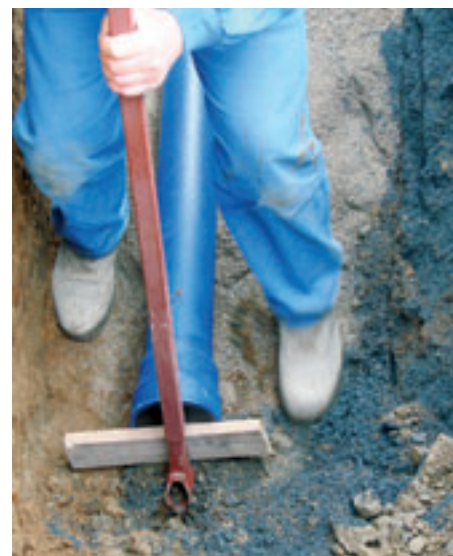
Projekt Sedlčany – krok 3 – ruční montáž pomocí tyče a konečné překrytí smontovaného spoje manžetou
