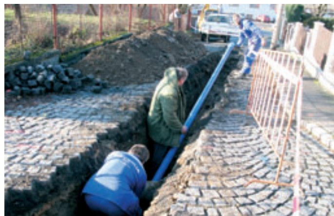
Projekt Sedlčany – ruční manipulace s trubkami
