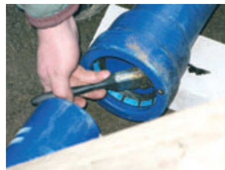
Projekt Sedlčany – krok 2 – namazání hladkého konce trubky a nasazení těsnícího kroužku
