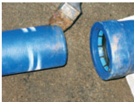
Projekt Sedlčany – krok 2 – namazání hladkého konce trubky a nasazení těsnícího kroužku
