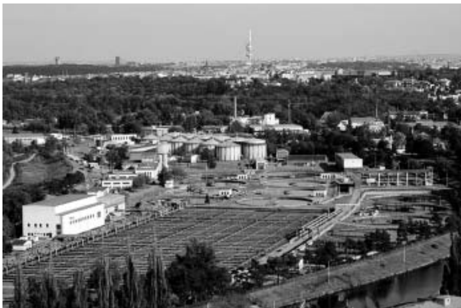
Císařský ostrov v Praze – Ústřední čistírna odpadních vod
