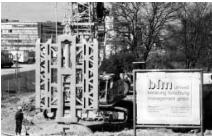
Obr. 7: Stavba štětové stěny
