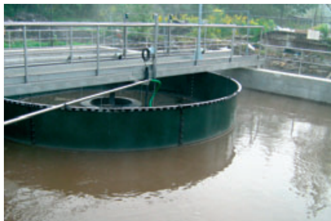
Obr. 7: Pohled na dosazovací nádrž
