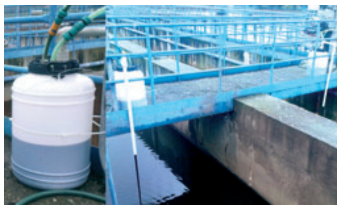
Obr. 4: Dávkovací zařízení externího substrátu do postdenitrifikace
