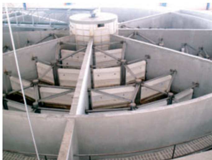
Unikátní vestavba děrovaných stěn do původní nefunkční kruhové flokulační nádrže na ÚV Hradiště
