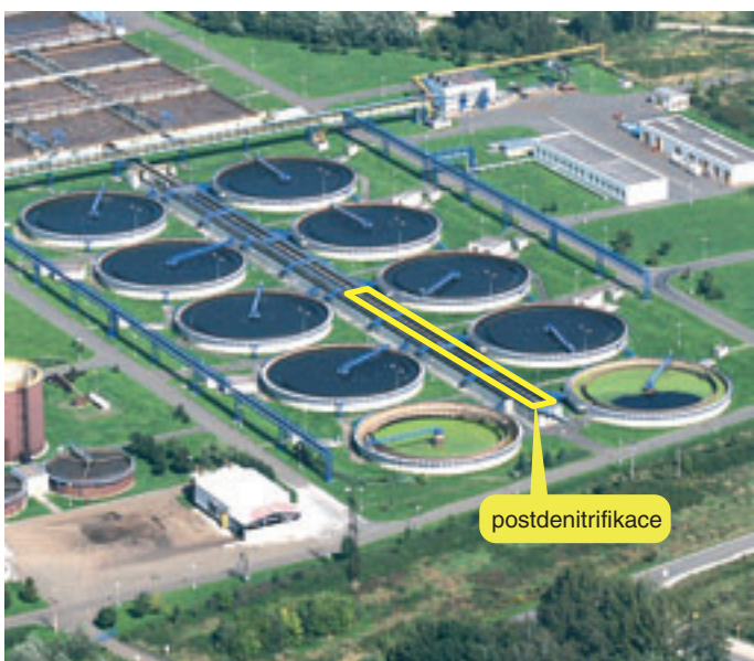
Obr. 3: Náhled na ÚČOV Ostrava s vyznačením postdenitrifikace
