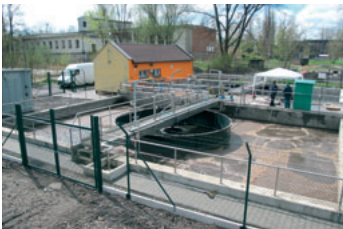
Obr. 6: ČOV po rekonstrukci
