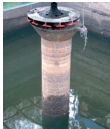
Obr. 5: Kompletní pohled na aerační turbínu
