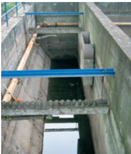
Obr. 3: Vystrojení dosazovací nádrže
