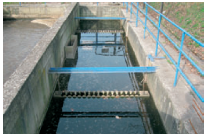
Obr. 2: Podélná dosazovací nádrž
