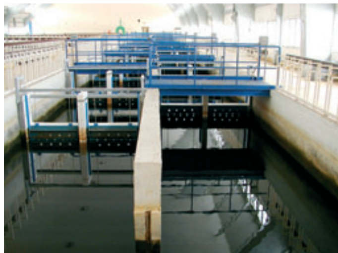
Jednoduché (nenastavitelné) děrované stěny pro přípravu suspenze na ÚV Bedřichov nahradily nevyhovující mechanická míchadla
