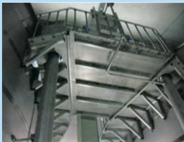
Obr. 4: Podesta pro obsluhu (zdola) pro bezpečnou a jednoduchou kontrolu
