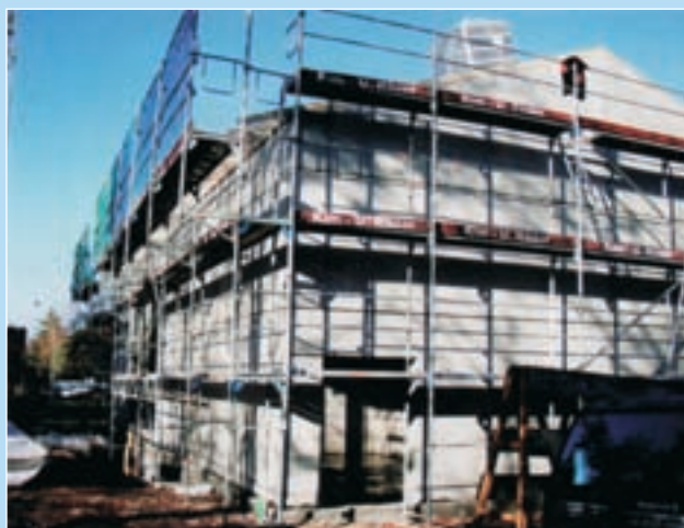
Obr. 3: Stavba budovy z prefabrikovaných betonových dílců
