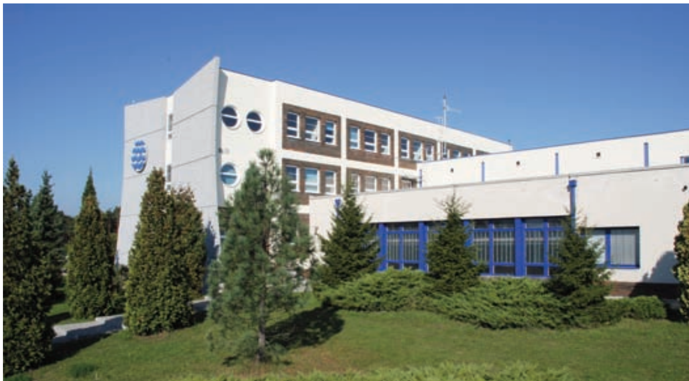
Úprava vody Klečůvka u Zlína
