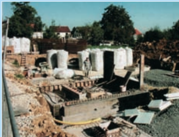
Obr. 2: Stavba základové desky s drážkami-kanály pro vedení potrubí
