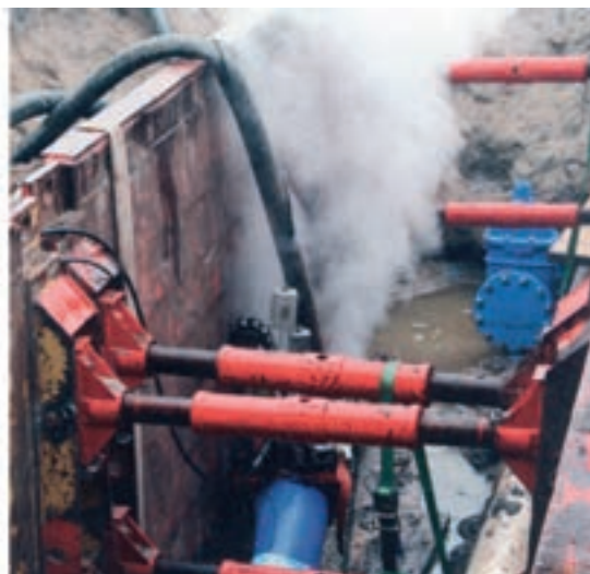
Obr. 5: Vložka-egelinér po propařování
