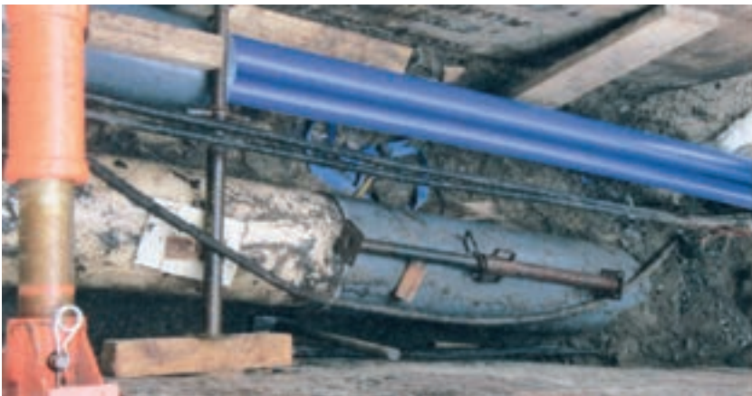
Obr. 1: Zatahování vložky-egeliner z malé stavební jámy za stísněných poměrů
