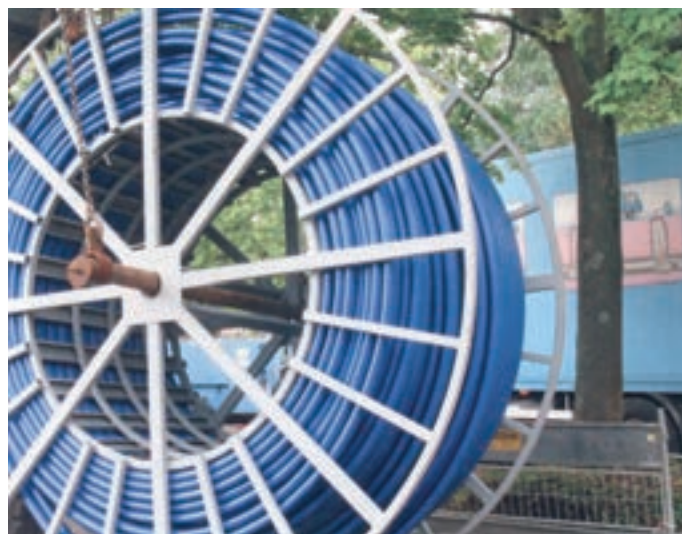
Obr. 3: Upravená vložka-liner navinutá na bubnu
