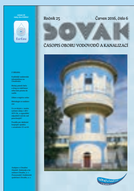
Titulní strana: Vodojem v Chrudimi. Vlastník: Vodovody a kanalizace Chrudim, a. s. Provozovatel: Vodárenská společnost Chrudim, a. s.
