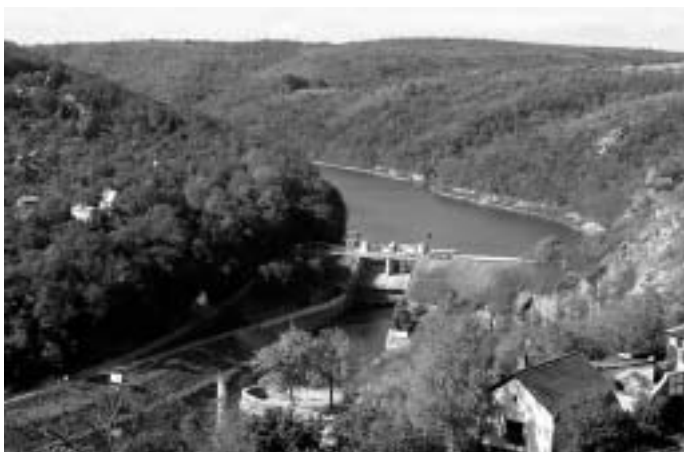
Hráz vyrovnávací nádrže Znojmo na řece Dyji. Byla uvedena do provozu v r. 1966 a slouží k vyrovnávání denních průtoků, zásobení pitnou vodou a využití vodní energie Výška hráze: 17,1 m, obsah nádrže: 4 290 000 m 3
