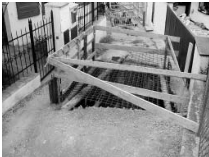
Extrémně úzké uličky pod Oborou Hvězda v Praze-Liboci jsou ideálním řešením pro uplatnění bezvýkopového řešení, pokud to umožní geologické podmínky
