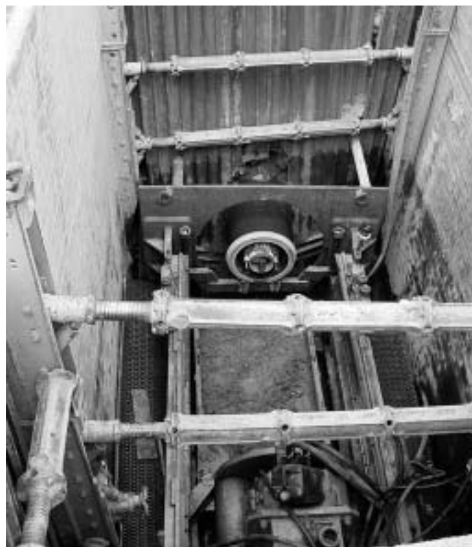
Ukončení vynášení odtěžené zeminy a nasazení další kameninové trouby DN 500 mm délky 1 m
