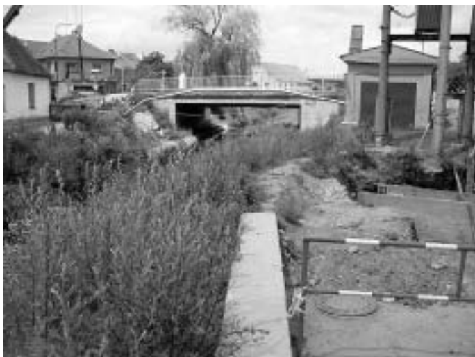
Jaroměřice nad Rokytnou, mikrotuneláž DN 500 mm – 42 m pod potokem Rokytky, vpravo u potoka cílová jáma s prostoupivším pilotním vrtem, vlevo před mostkem startovací jáma s jeřábem
