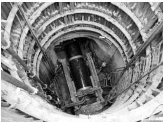
Pohled do více jak 11 m hluboké startovací jámy v Ostravě, Staré Bělé. Uvnitř jámy kameninová trouba DN 800 mm, délky 2 m. Tlačí se cca 100 m tohoto potrubí ve 4 promilovém spádu s přesností na \pm 1 cm(!) hluboko pod hladinou spodní vody
