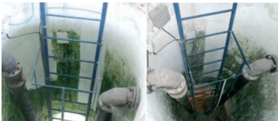
Obr. 2: Nátěry aplikované v prostoru věžového vodojemu v roce 2008 (obrázek vlevo) a následně kontrolovány v roce 2011 (obrázek vpravo). Je patrná vysoká odolnost a účinnost nátěru P-Si (pás nalevo od žebříku), oproti nátěru P-55 (pás napravo od žebříku), který zelená a je nestabilní.
