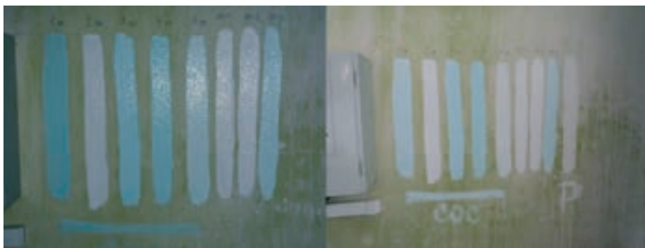
Obr. 3: Nátěry aplikované na stěně v prosvětleném prostoru technologické linky s nárosty řas a sinic v roce 2012. Je patrná nestálost některých nátěrových systémů (blednutí, drolení). Pro účely dalšího sledování byl natřen i kontrolní pás (P) Primalexem.
