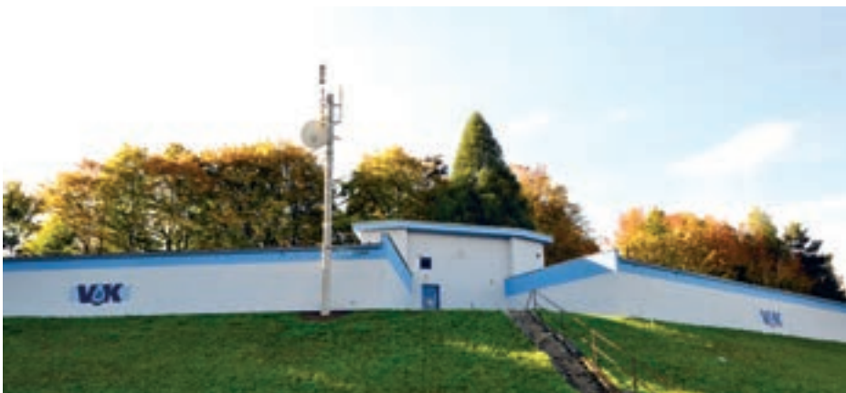
Vodojem Vsetín – Bečevná
