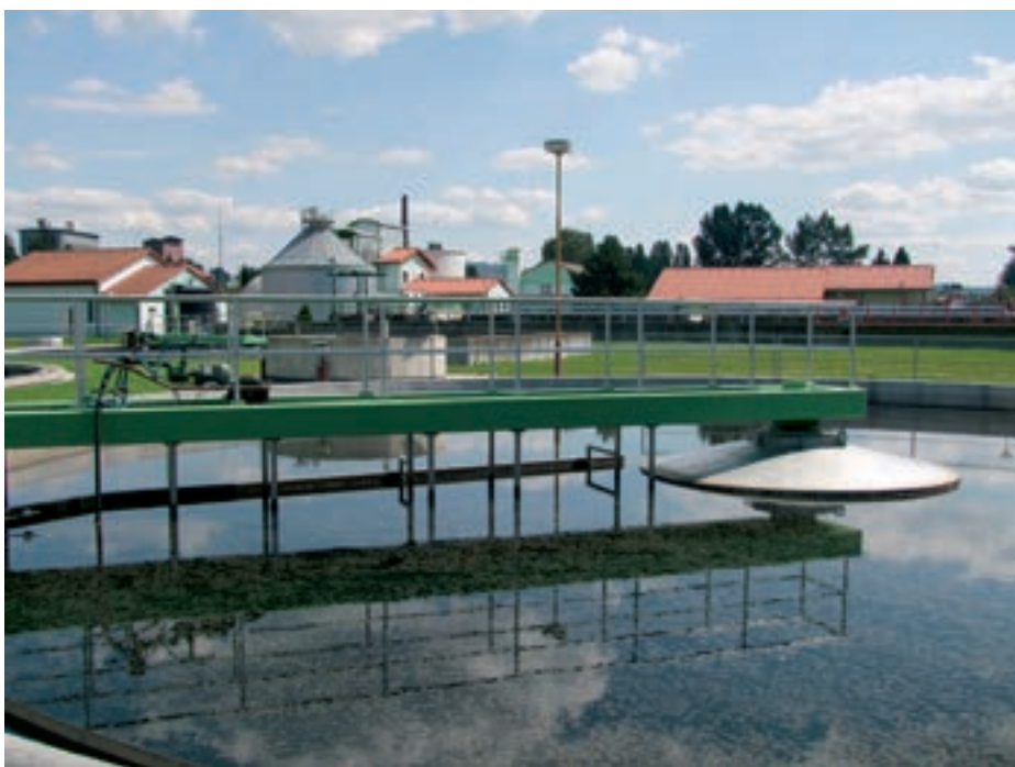
ČOV Valašské Meziříčí
