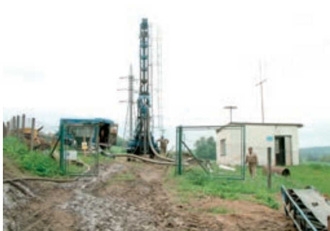
Obr. 15: Vybudování náhradního jímacího vrtu pro odběr podzemní vody
