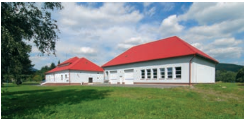
Úpravna vody Rožnov pod Radhoštěm
