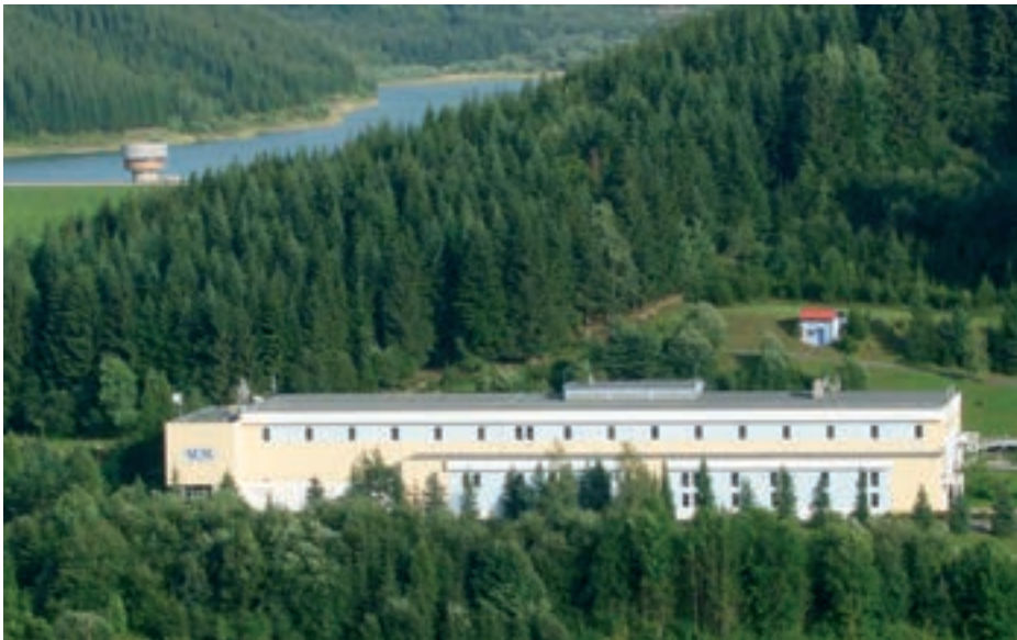
Úpravna vody Karolinka
