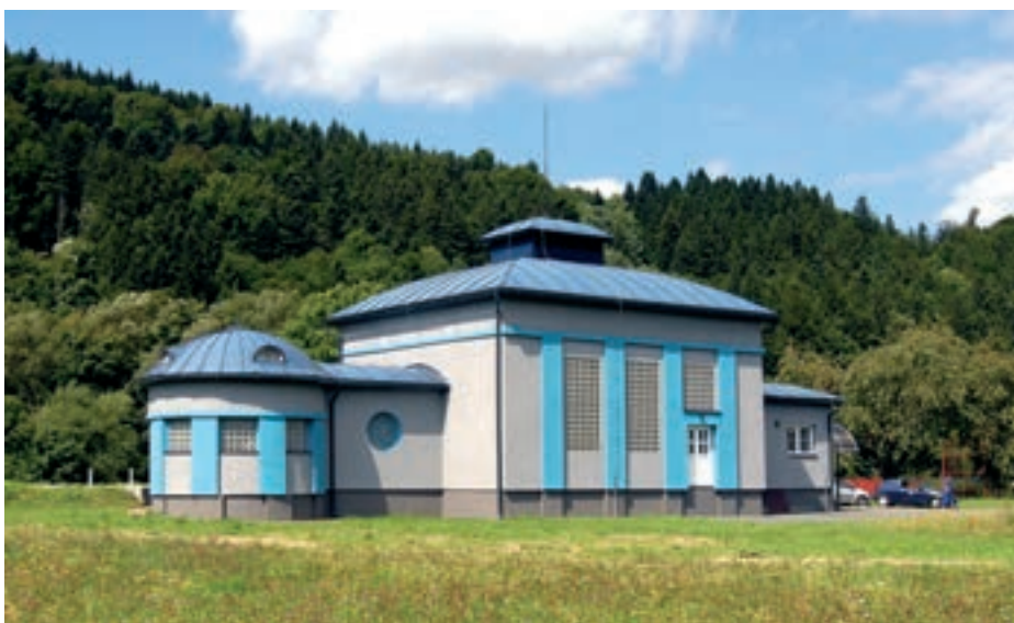
Čerpací stanice Vsetín – Ohrada
