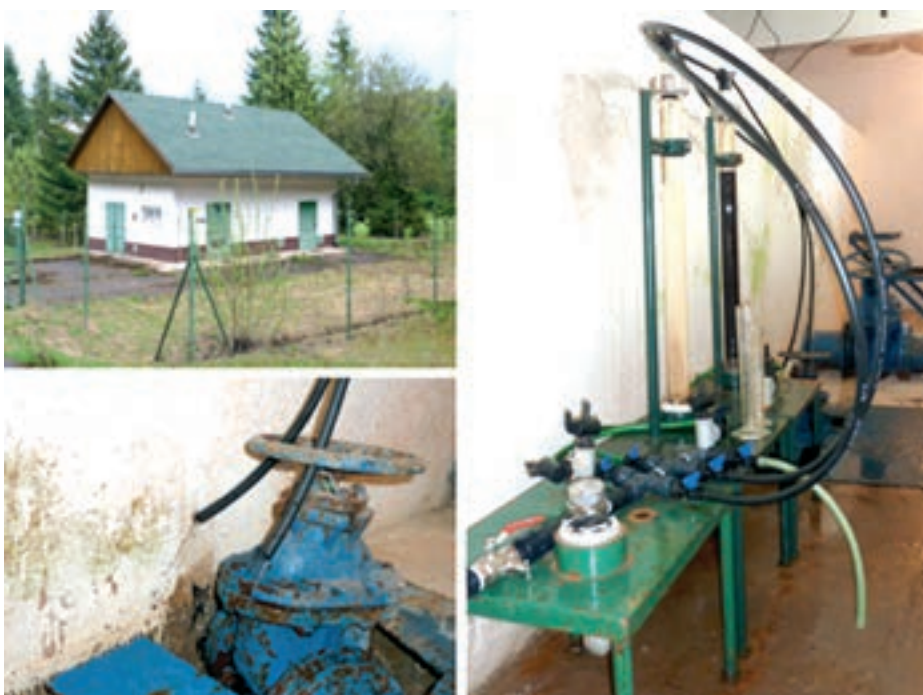
Obr. 1: Pohľad na vodárenský objekt v Dúbrave, použité zariadenie a odber vzoriek
