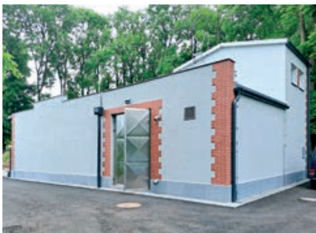
Obr. 1: Přístavby k původní stavbě chlorace výtlačku z prameniště Krásná
