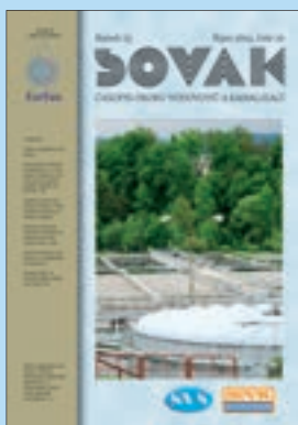
Titulní strana: ČOV Liberec. Vlastník: Severočeská vodárenská společnost a. s. Provozovatel: Severočeské vodovody a kanalizace, a. s.
