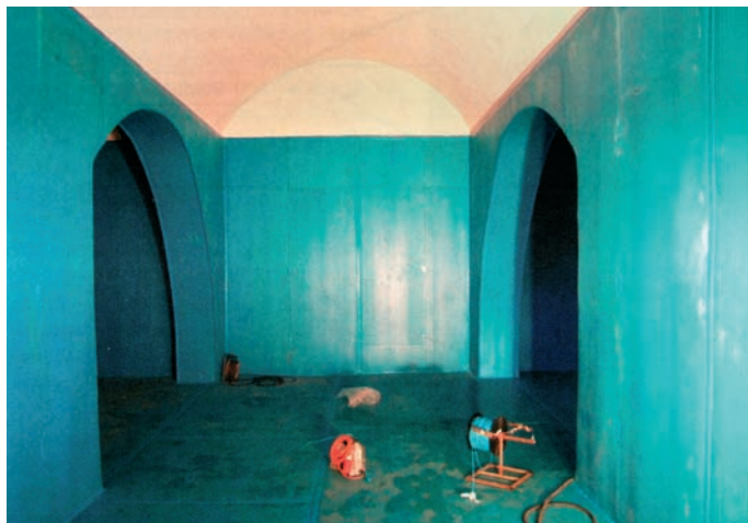
Obr. 7: Komora vodojemu po sanaci
