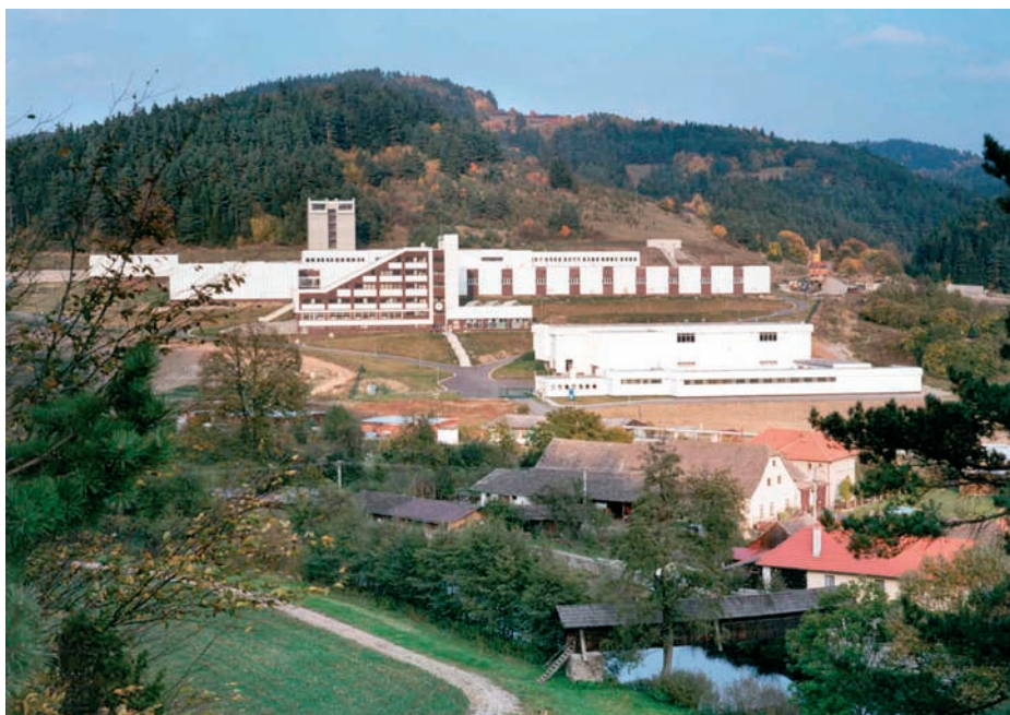
Úpravná vody Švařce
