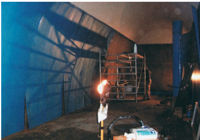
Obr. 5: Montáž polypropylenových desek
