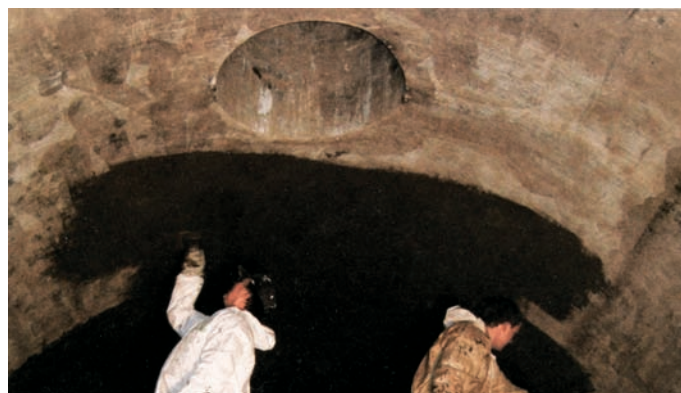
Obr. 3: Sanovaný strop nádrže
