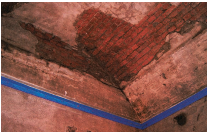
Obr. 2: Klenutý strop po vyčištění vysokotlakou vodou
