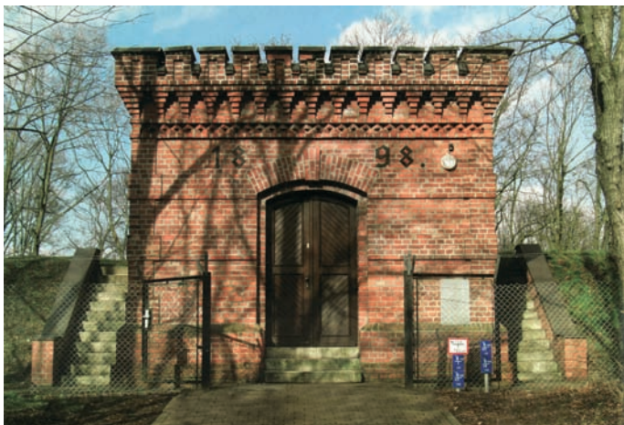
Obr. 1: Vodojem na pitnou vodu „Na starém hradě“
