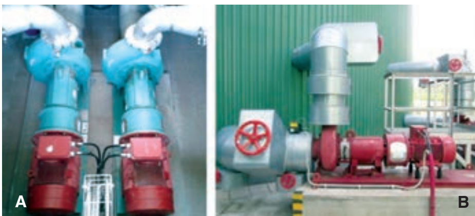
Obr. 9A: Uložení čerpadel systému Rotamix® na ČOV Bystřany, B: Uložení čerpadel systému Rotamix® na ÚČOV Praha, C: propojovací šoupě mezi čerpadly na ČOV Bystřany
