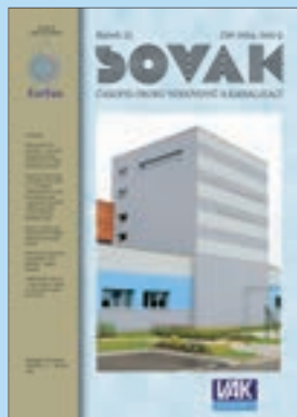
Titulní strana: Vodovody a kanalizace Kroměříž, a. s. – úpravná voda
