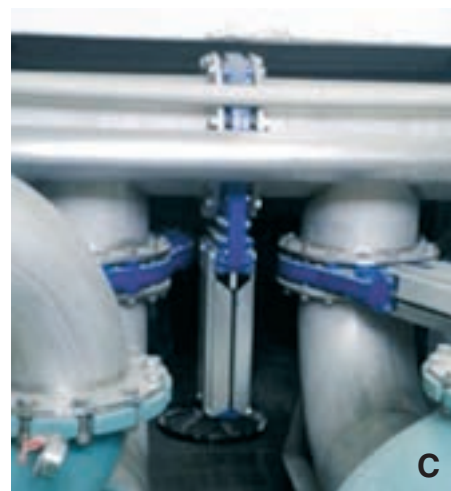
Obr. 9A: Uložení čerpadel systému Rotamix® na ČOV Bystřany, B: Uložení čerpadel systému Rotamix® na ÚČOV Praha, C: propojovací šoupě mezi čerpadly na ČOV Bystřany
