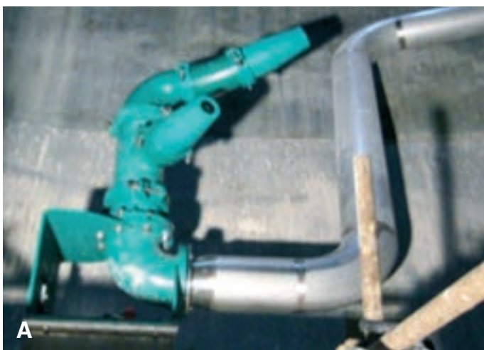
Obrázek 1A: Dvojité trysky umístěné ve spodní části vyhnivací nádrže, B: Princip systému Rotamix® (verze bez horních trysek)
