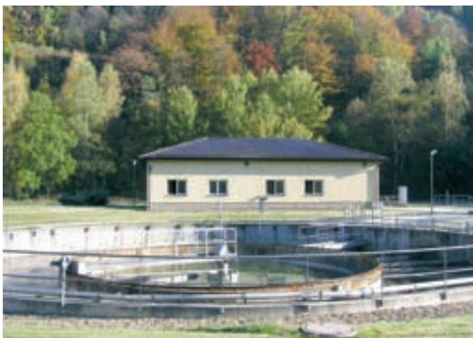
Pohled na ČOV Tanvald
