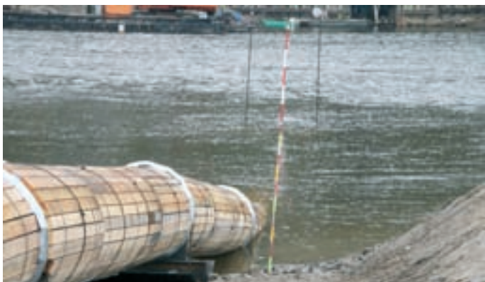
Obr. 8: Dolní konec shybky se ponořuje do vody
