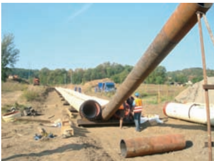
Obr. 4: Montáž konstrukce na břehu
