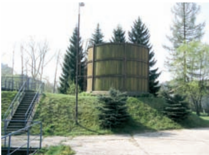
Pohled na biofiltr
