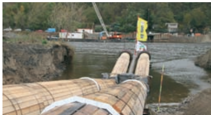
Obr. 7: Shybka připravena k finálnímu zatažení
