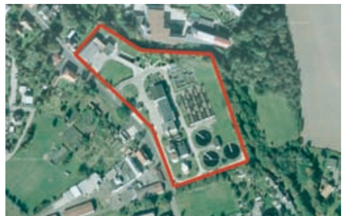
Letecký snímek ČOV Varnsdorf před rekonstrukcí
