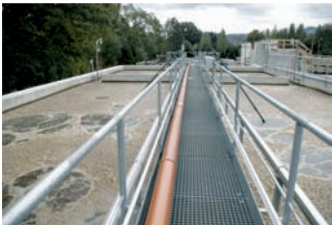
Provizorní čerpání odpadní vody do regenerace kalu
