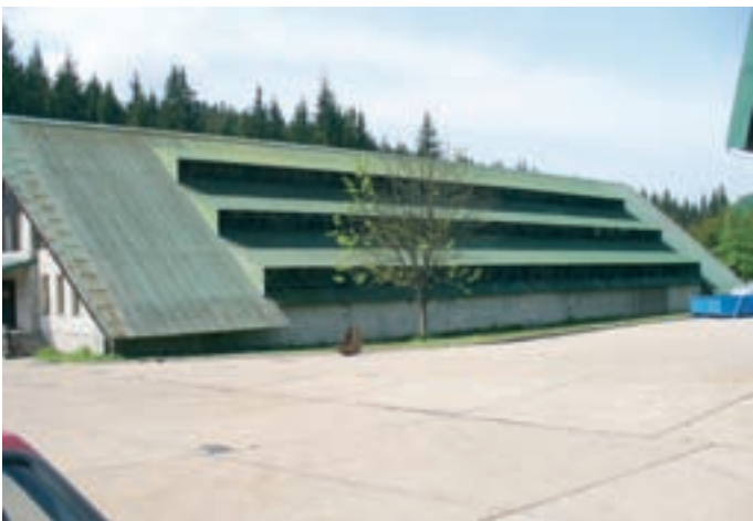
Budova ČOV Harrachov
