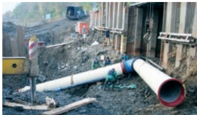
Obr. 9: Montáž propoje shybky s armaturními komorami
