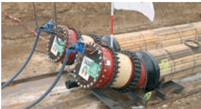
Obr. 6: Sestava na horním konci shybky pro napouštění trubek
