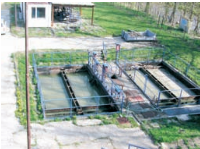
Pohled na hrubé předčištění a štěrbínové nádrže ČOV Velké Hamry
