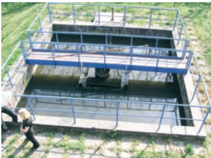
Dosazovací nádrž a kalojem
