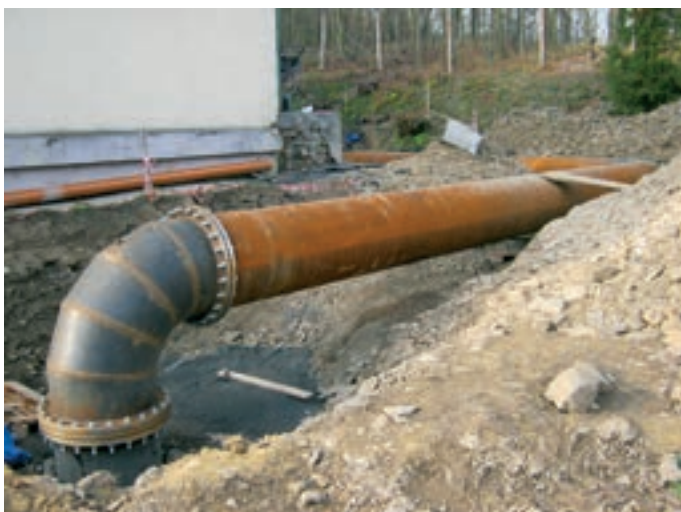
Potrubí provizorního obtoku DN 800, napojení na odtokové potrubí DN 1 200
