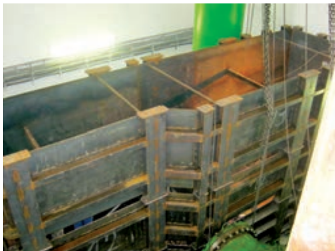
Montáž vývarové vany
