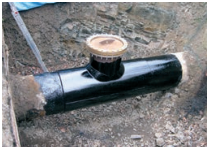
Odbočka pro provizorní obtok na přítokovém potrubí DN 1 000
