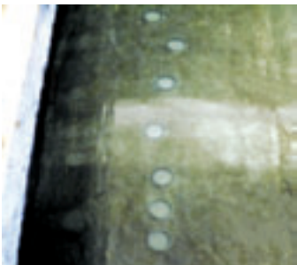
Obr. 1: Terče s geotextilií umístěné na povrchu filtru
