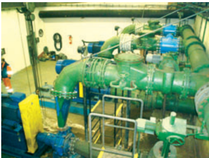
Obr. 2: Paralelní uspořádání čerpadel v ČS
