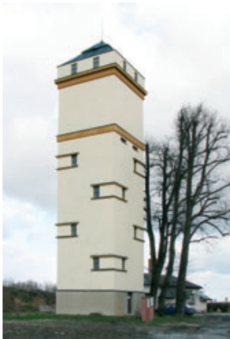
Vodojem Horní Cetno
