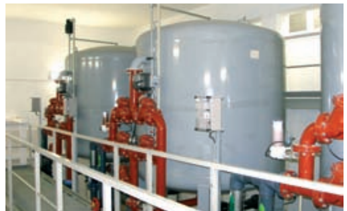
Obr. 9: Úpravna vody Hájek, odželeznění, kapacita 45 l/s
