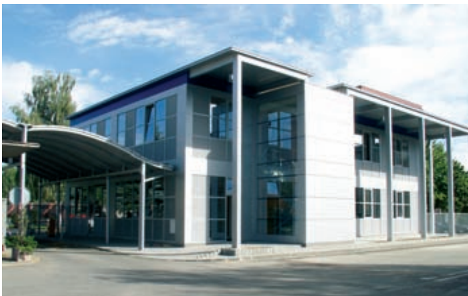
Obr. 1: Vstupní budova areálu Vodovody a kanalizace Hradec Králové, a. s.
