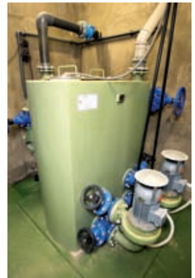
Obr. 8: Kanalizační čerpací stanice se separací pevných látek pro 1 500 obyvatel
