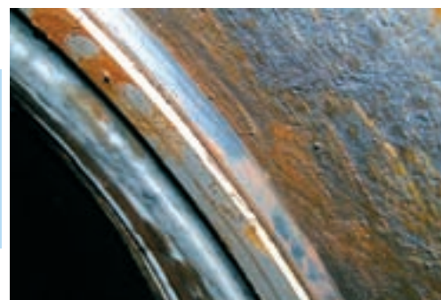
Detail přilnutí opravného pasu k potrubí
