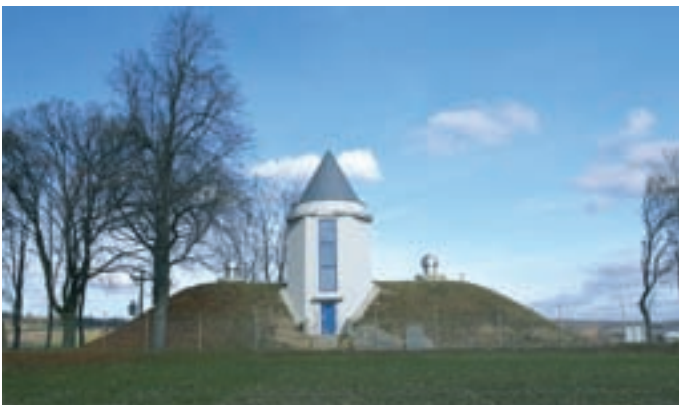
Obr. 7: Vodojem Třebechovice pod Orebem, kapacita 2 x 350 m 3
