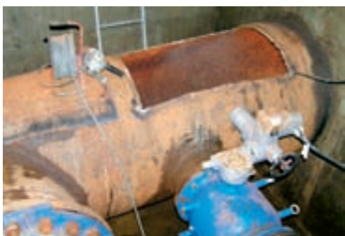
Výřez na potrubí v šachtě před armaturní komorou vodojemu
