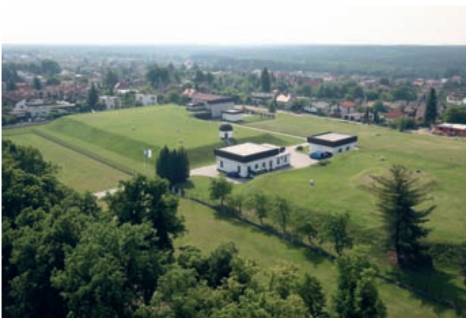
Obr. 3: Pohled na podzemní vodojem v Hradci Králové, kapacita 48 000 m 3
